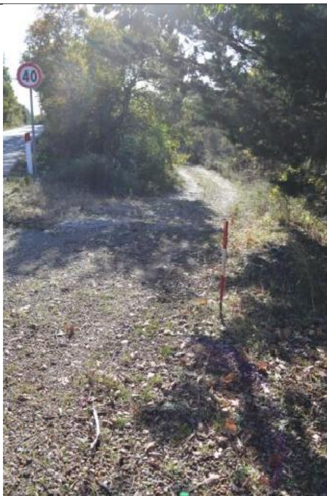
Foto 3: UR1, tratto cavidotto
