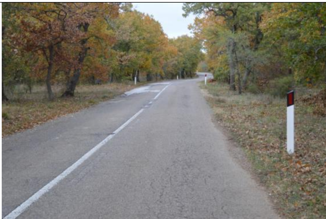
Foto 1: UR9, area del cavidotto verso l' aerogeneratore 1
