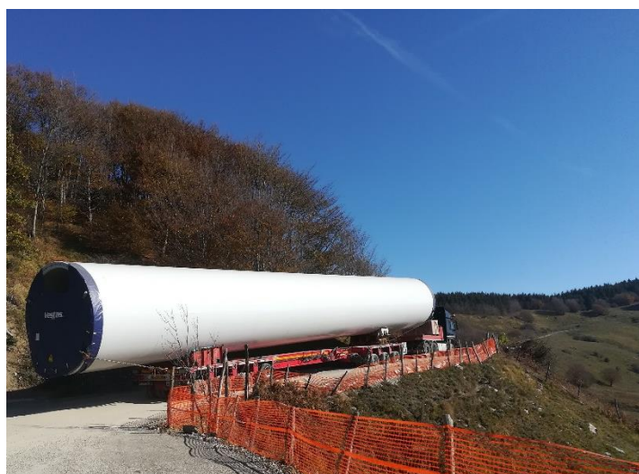
Figura 2 - Trasporto con convoglio semovente
