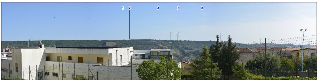
Figura 55 - Stato dei luoghi post operam
