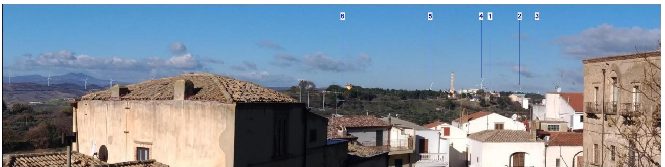
Figura 50: Stato dei luoghi post operam
