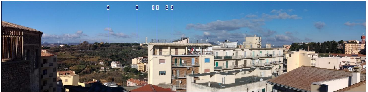
Figura 49: Stato dei luoghi post operam
