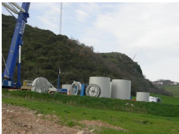
**Figura:** elementi torre smontata da trasportare
