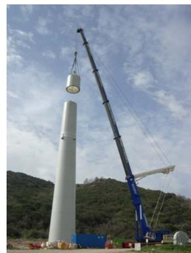
**Figura:** rimozione eliche, mozzo e trami
