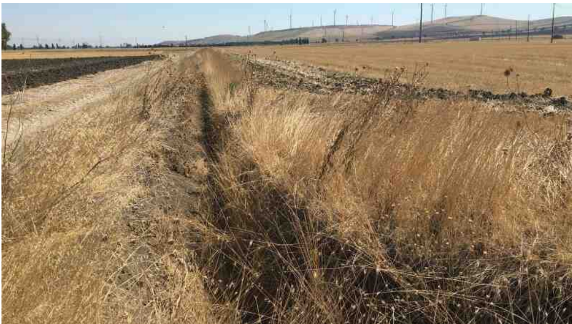
Foto n.19 - In corrispondenza di RS = 1192.93
