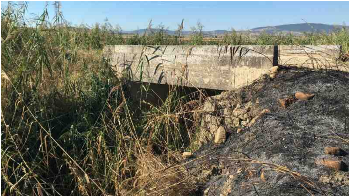
Foto n.32 - Canale tombato a sezione circolare (RS = 177)
