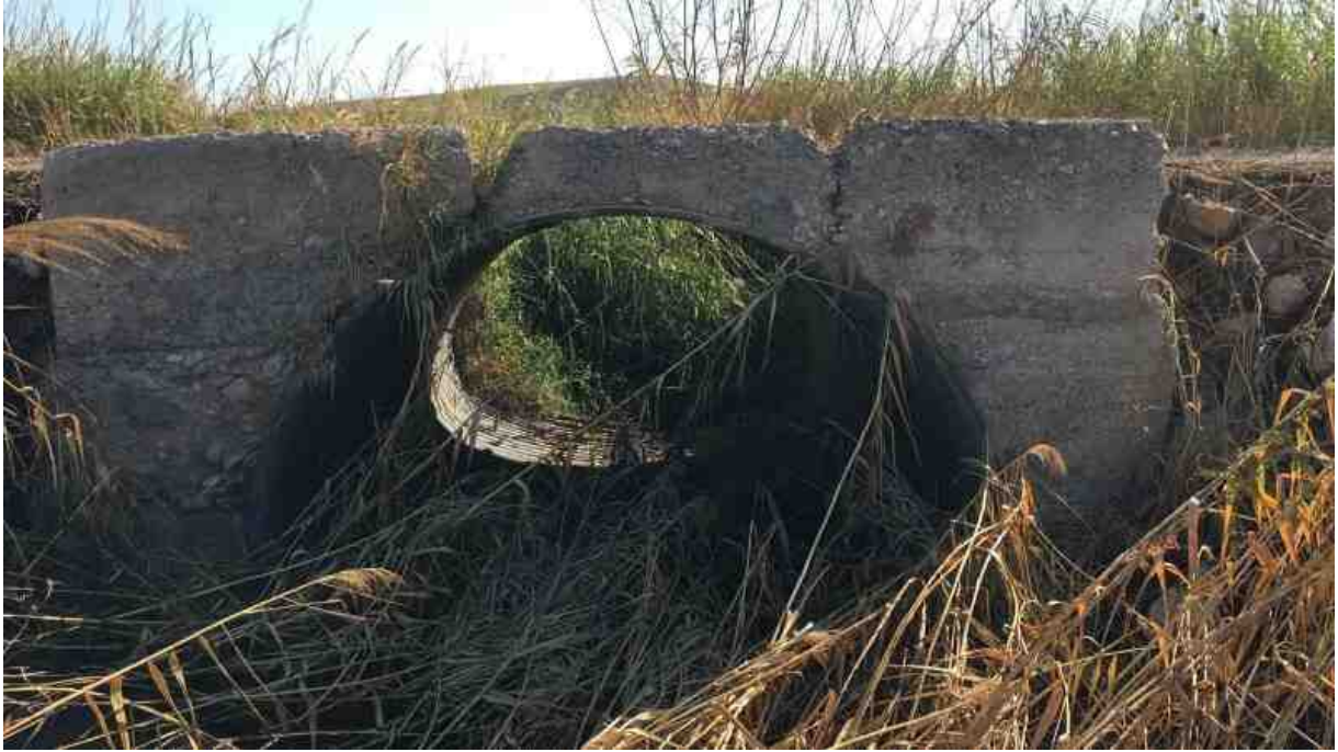
Foto n.31 - Canale tombato a sezione circolare (RS = 958)
