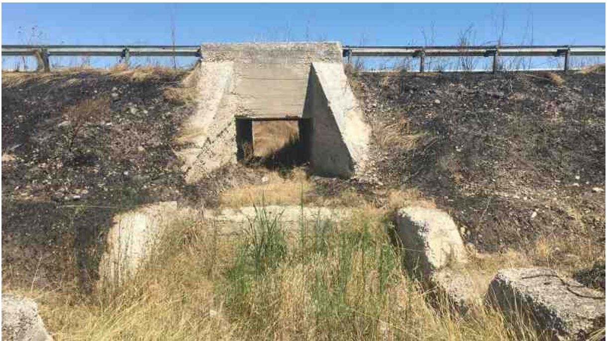
Foto n.35 - Canale tombato a sezione rettangolare (RS = 587)
