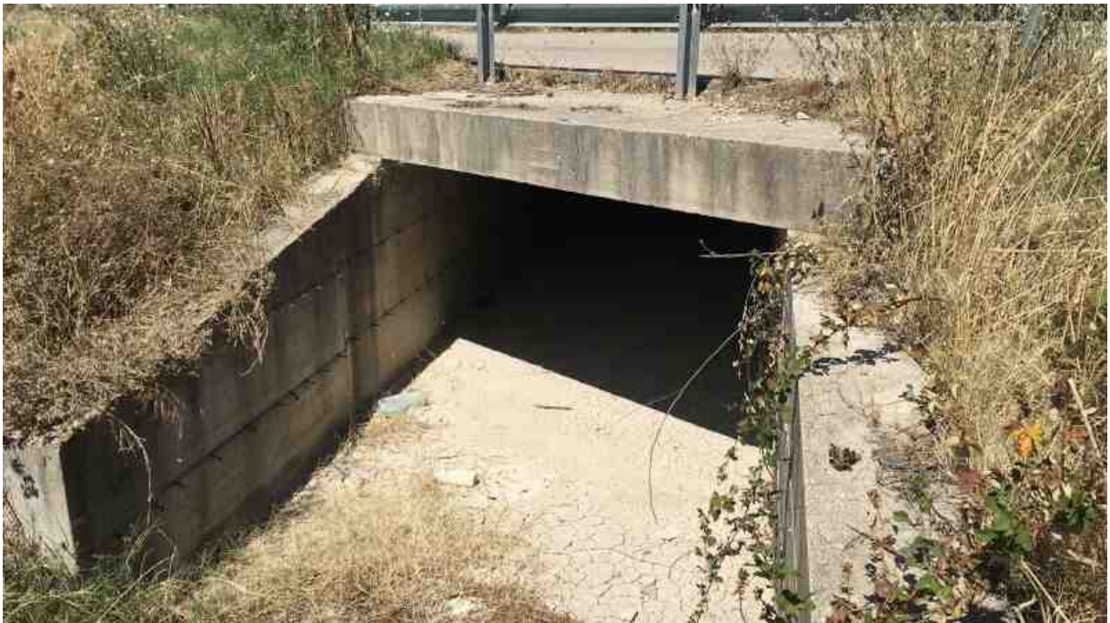
Foto n.50 - Canale tombato a sezione rettangolare (RS = 286)
