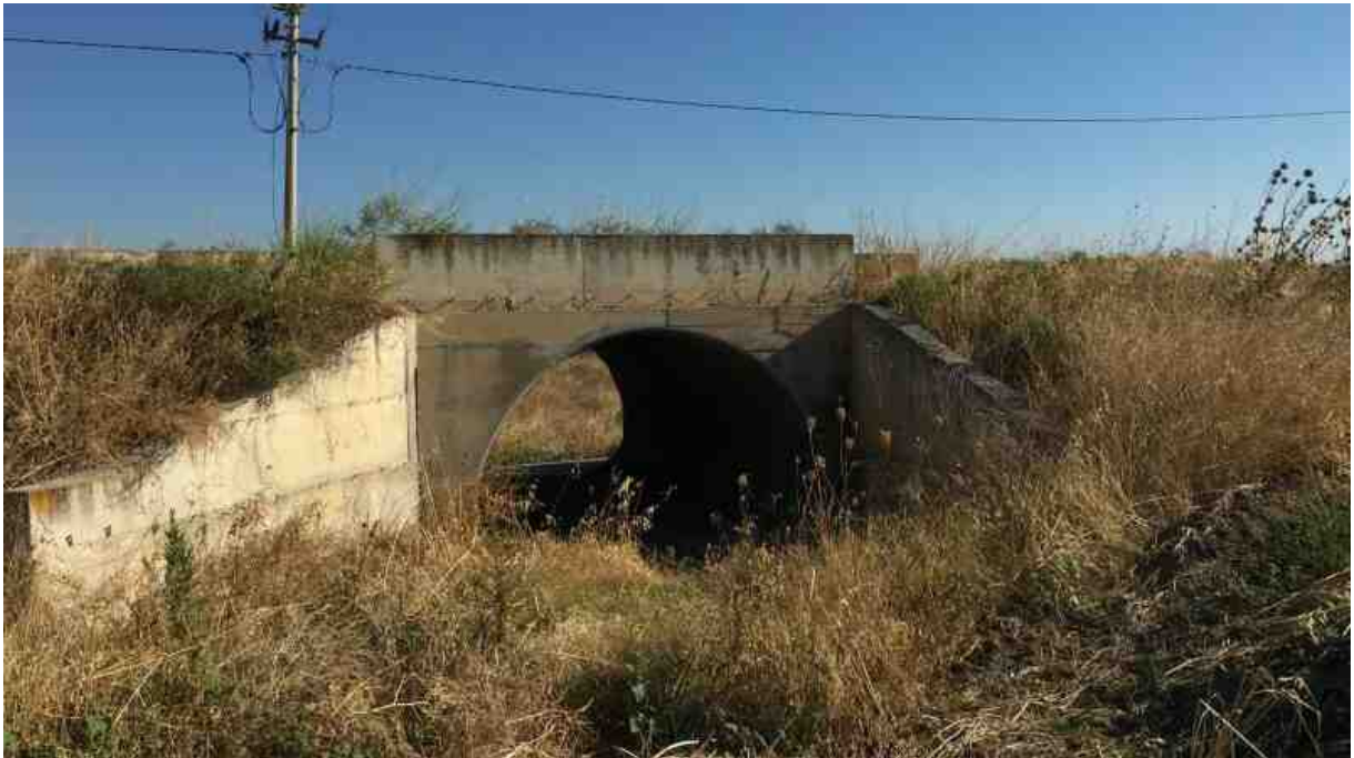
Foto n.44 - Canale tombato a sezione circolare (RS = 475)
