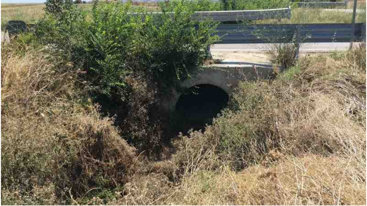
Foto n.49 - Canale tombato a sezione circolare (RS = 327)
