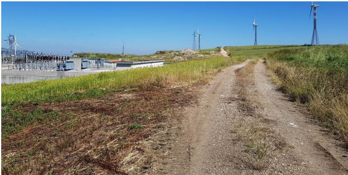
**Figura 15: tratti della strada che serve l'impianto esistente e da cui si accederà per la realizzazione degli aerogeneratori con sigle da R-BS01 a R-BS10. In alto si notano i danni fatti dal ruscellamento dell'acqua sulla sede stradale causato dalla cattiva tenuta delle cunette stradali. La strada avrà bisogno di sistemazione delle cunette, di interventi di allargamento della sede carrabile, di rifacimento della massicciata e di ricarica puntuale con stabilizzato di cava.**
