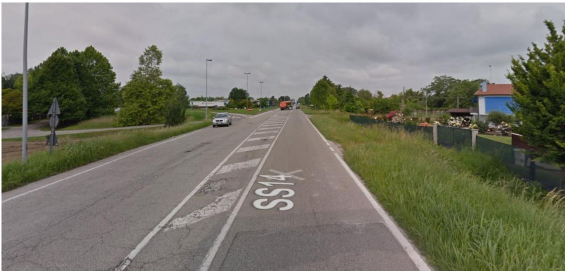
Vista n.2 – SS.14 direzione Portogruaro
