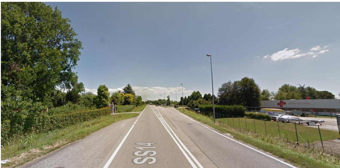
Vista n.3 - SS.14 direzione Latisana
