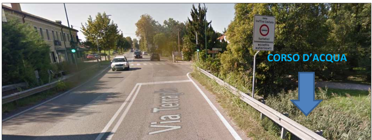
Figura 37: Zona 2 – vista da nord verso sud
