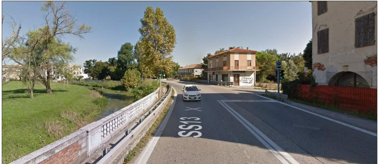
Figura 35: Zona 1 – vista da sud verso nord
