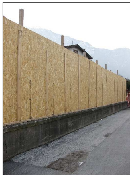
Figura 47 – Esempio barriere di limitazione cantiere con pannelli in legno
