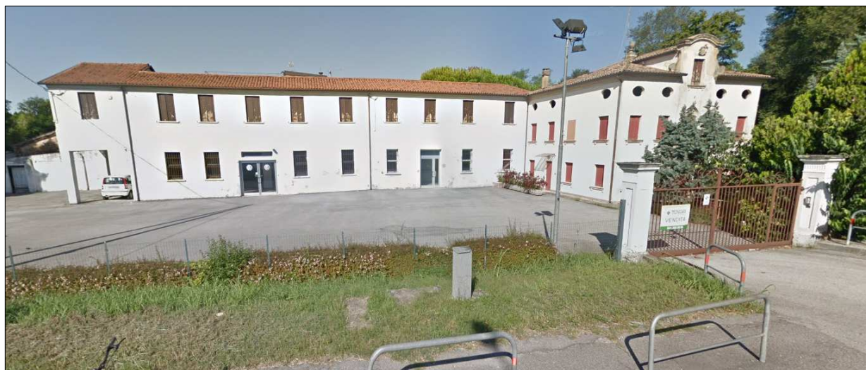
Figura 19 – Edificio tutelato all'incrocio tra Via Gatta e la SS13
