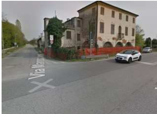
Figura 3 – Vista dell'incrocio tra Via Marocchese e la SS13
