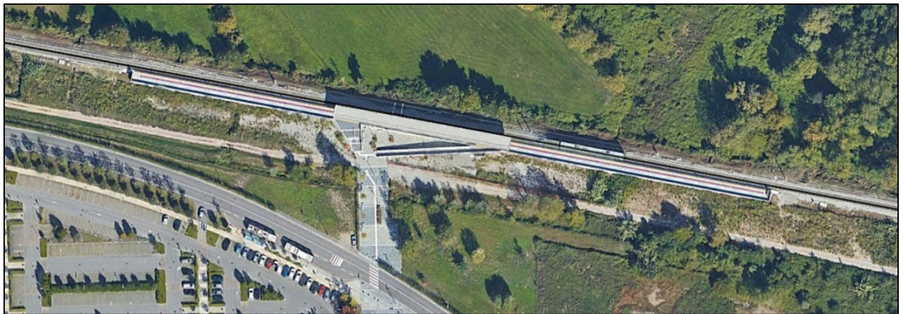
Stato attuale della stazione
