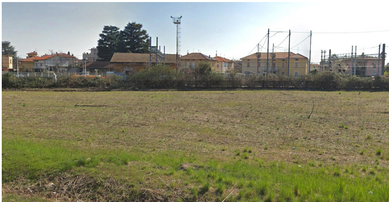
Figura 3 – Recinzione limite infrastruttura ferroviaria esistente
