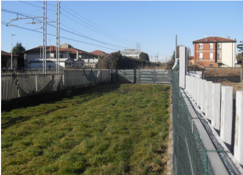
Foto 1 - Vista del cantiere CO.01 (fonte sopralluogo)
