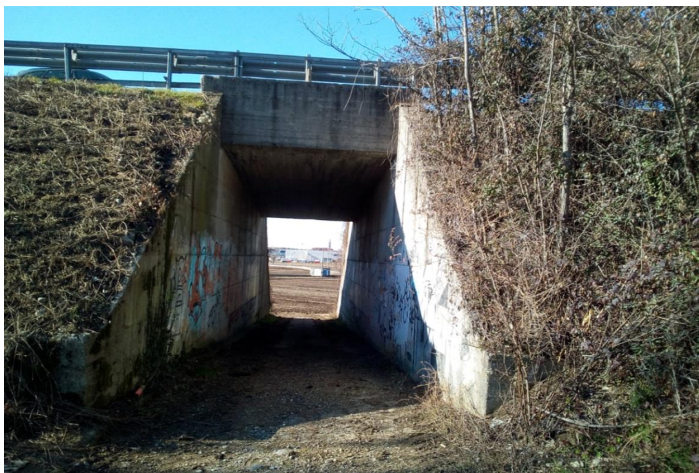
Vista del sottopasso esistente (fonte sopralluogo)
