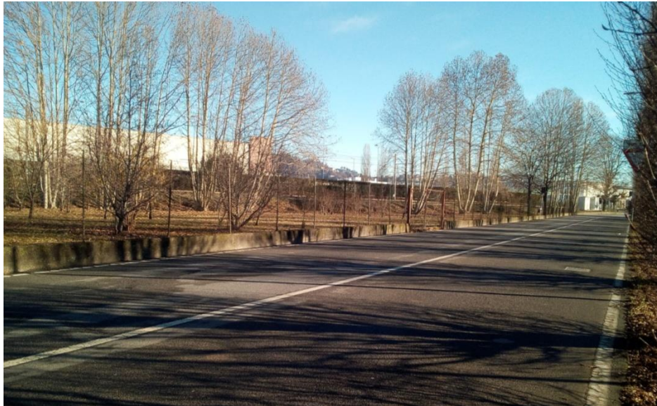
Foto 1 - Vista del cantiere CO.02 - (fonte sopralluogo)
