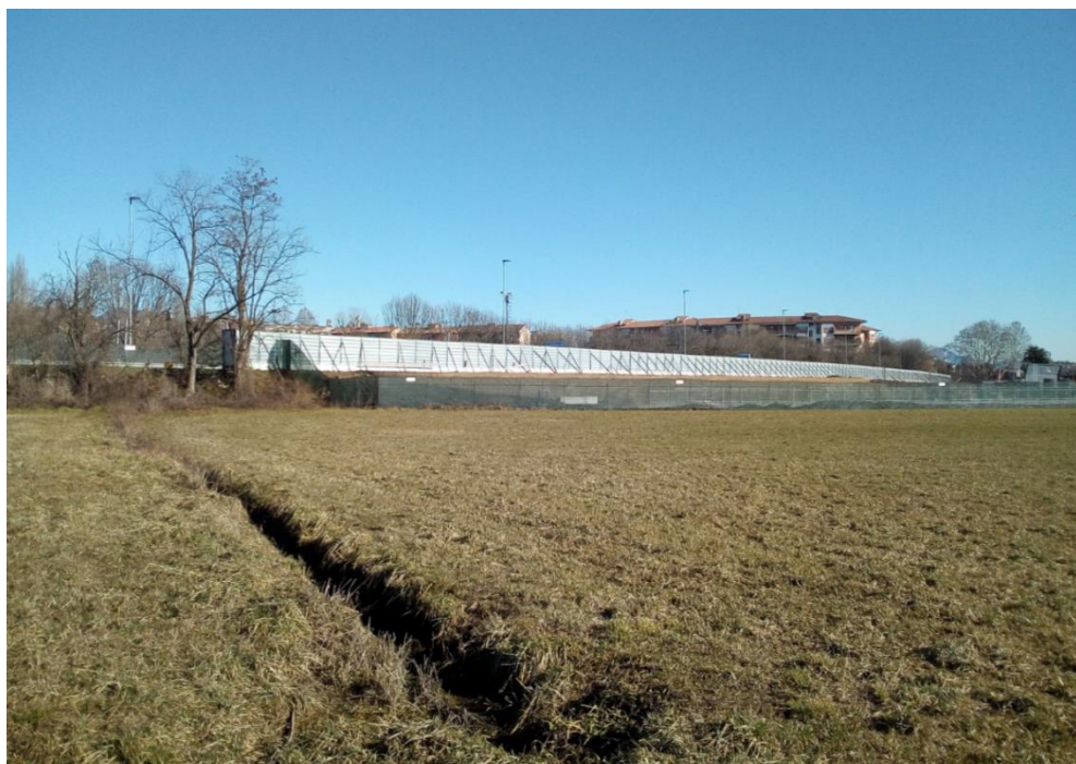
Foto 1 – Vista del Cantiere
