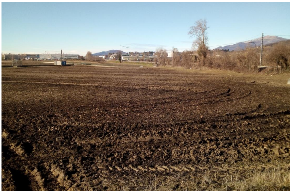
Foto1 - Vista del cantiere 1.CO.02 (fonte soprallugo)
