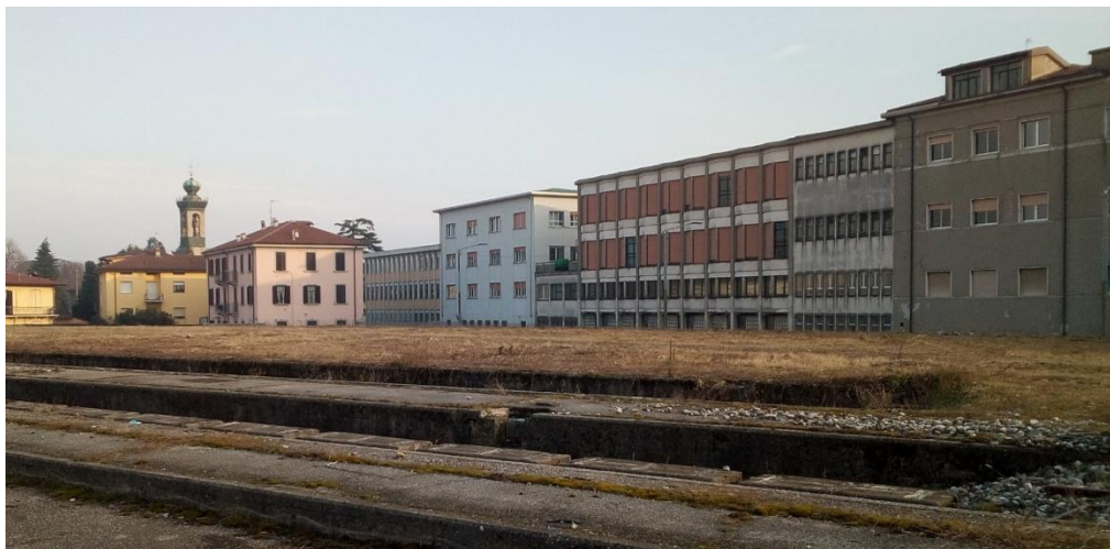
Foto 1 – Vista del cantiere dalla pista di accesso
