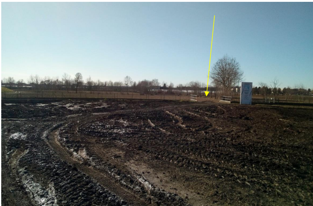
Foto1 - Vista del cantiere CB.01 e di uno degli attraversamenti idraulici presenti nell'area (fonte Sopralluogo)
