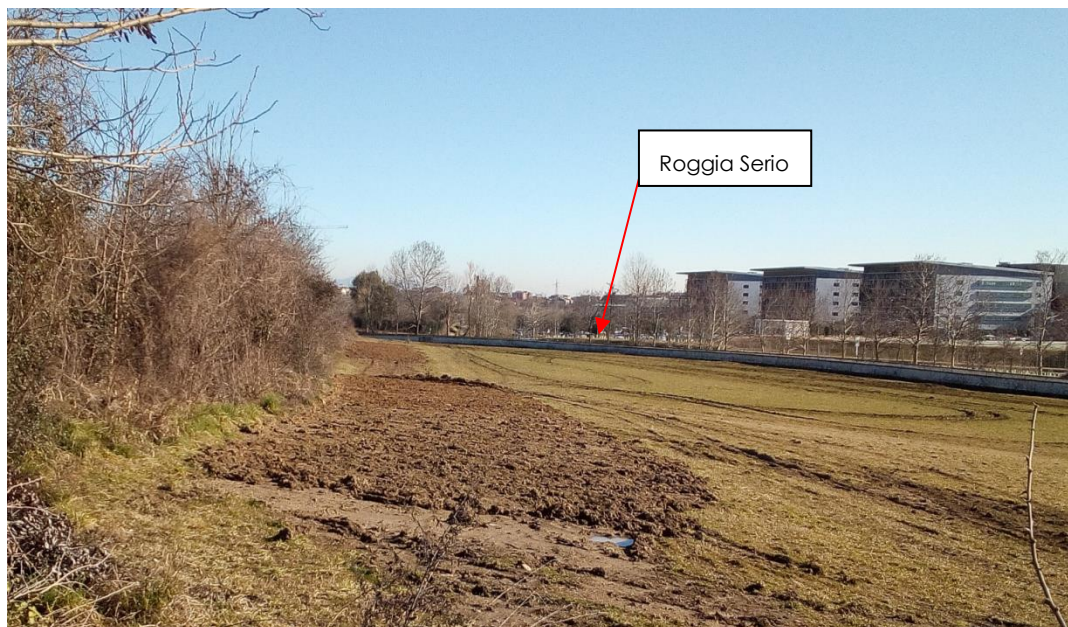
Foto 2 - Vista delle aree di cantiere sud -lato est (fonte sopralluogo)
