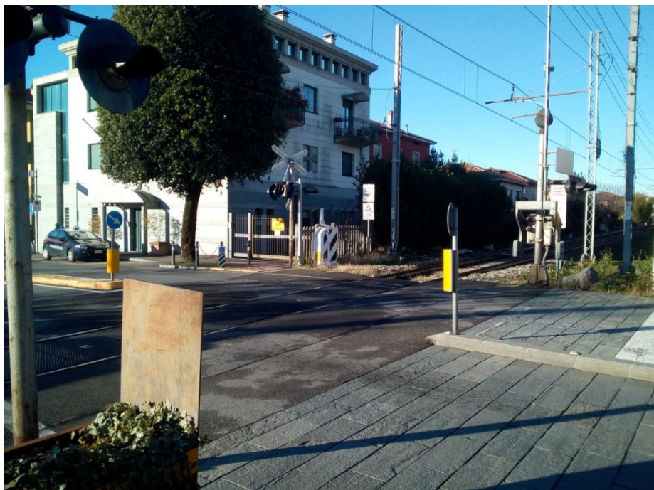
Foto2 - Vista del cantiere 1.AT.01 (fonte sopralluogo)
