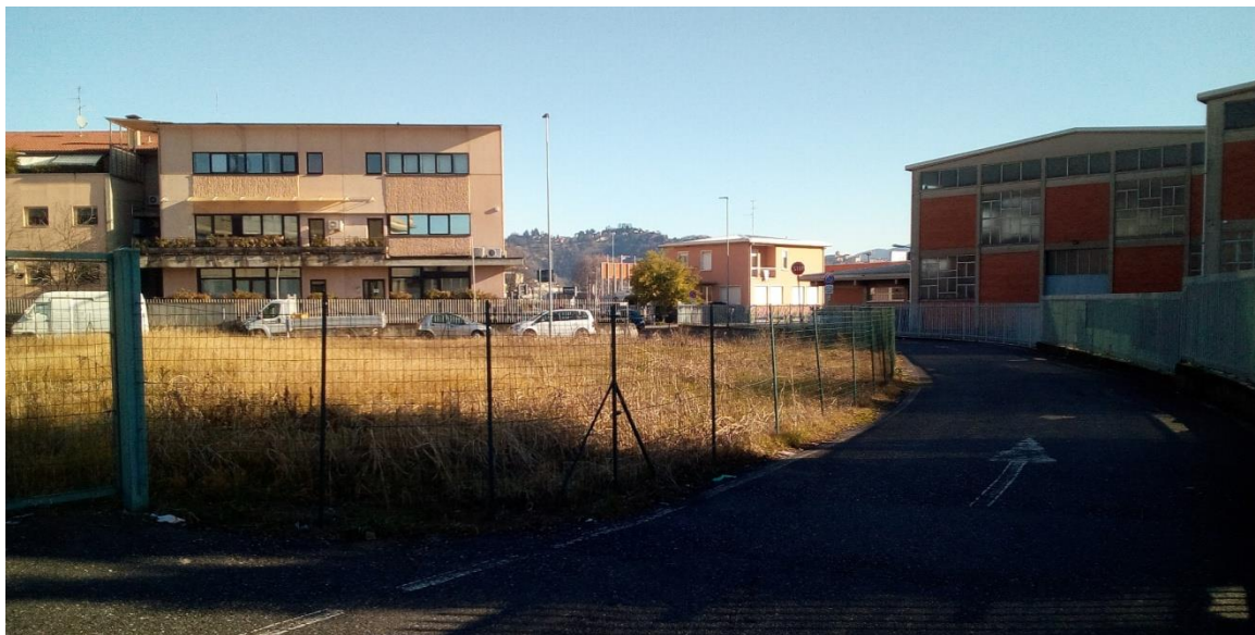
Foto 1 - Vista del cantiere 1.AS.01
