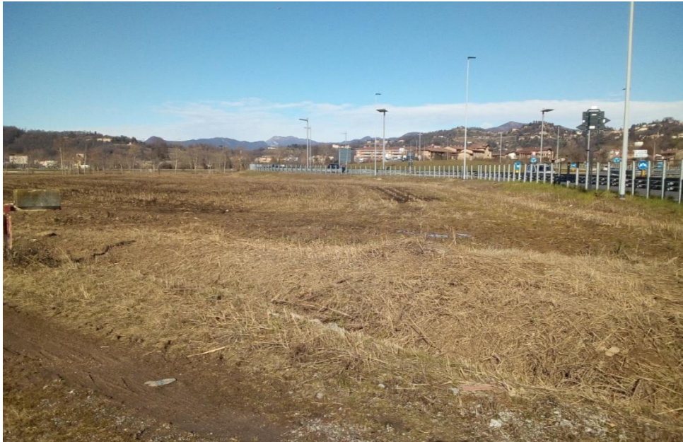
Foto1 - Vista del cantiere 1.AS.04 (fonte sopralluogo)
