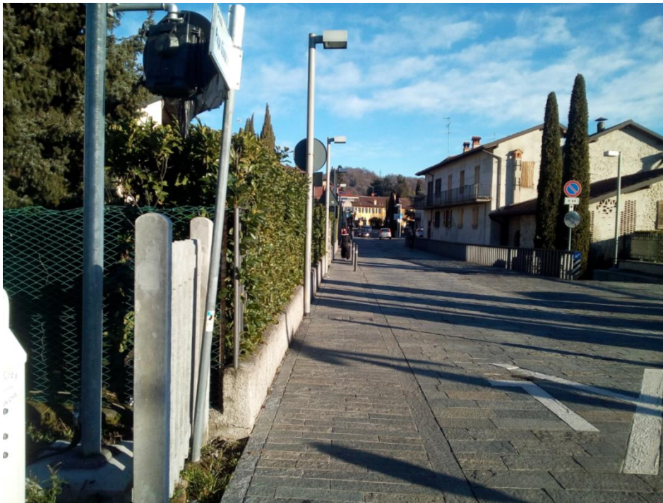
Foto1 - Vista del cantiere 1.AT.01 (fonte sopralluogo)
