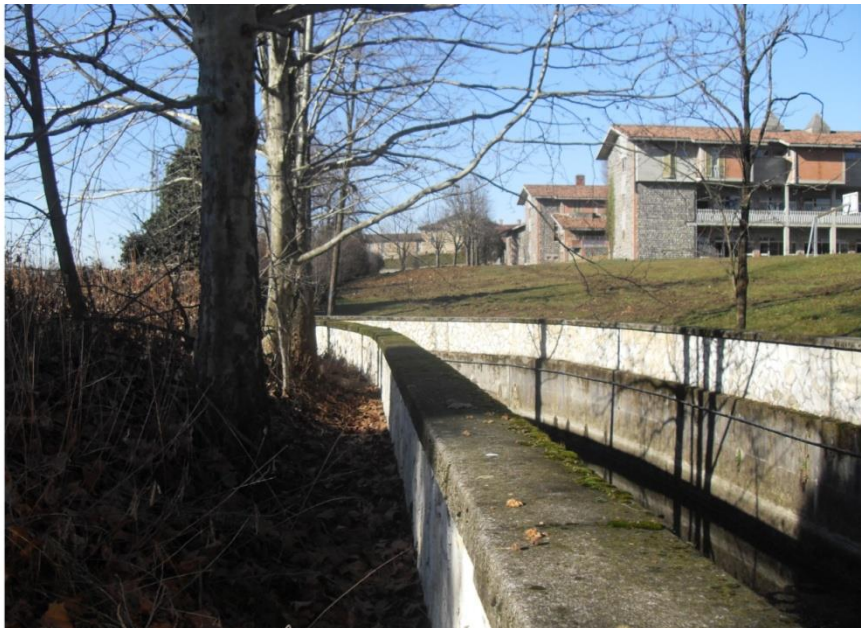
Foto 2 - Vista delle aree di cantiere nord (fonte sopralluogo)
