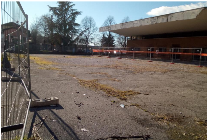
Foto1 - Vista dell'area di cantiere AS.06
