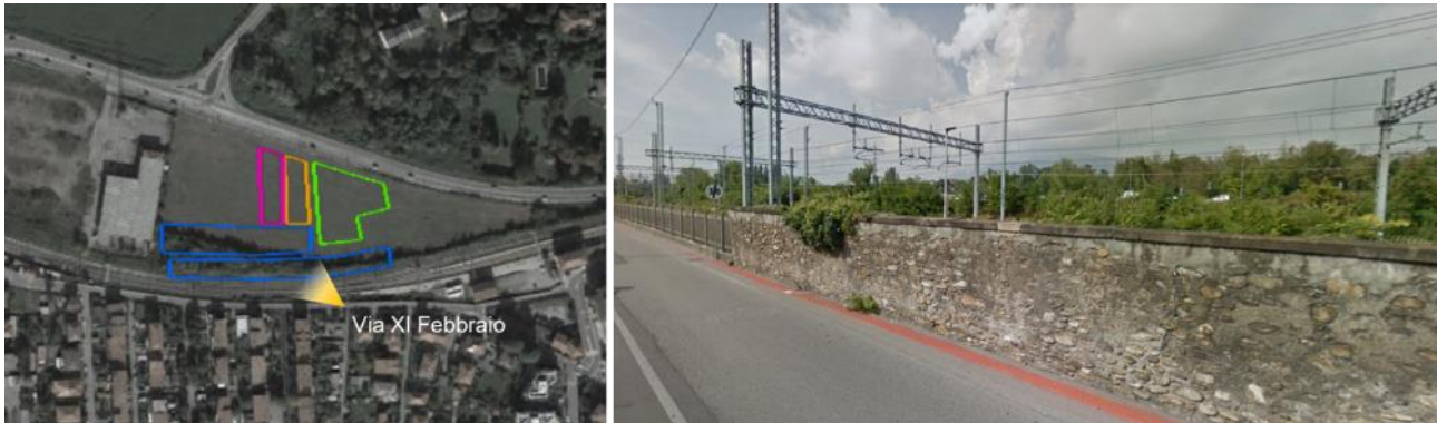
Figura 7-11 Aree di cantiere nei pressi della Stazione ferroviaria di Ponte San Pietro: visuale da Via XI Febbraio
