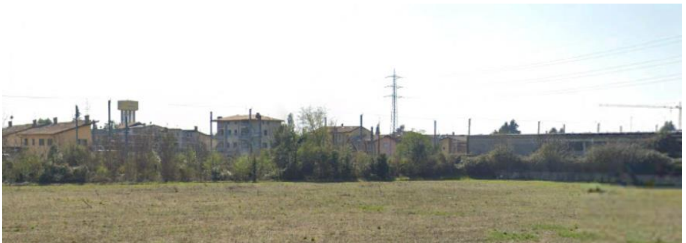
Figura 5-10 Rilievo fotografico dell'area di cantiere fisso 1.AR.02
