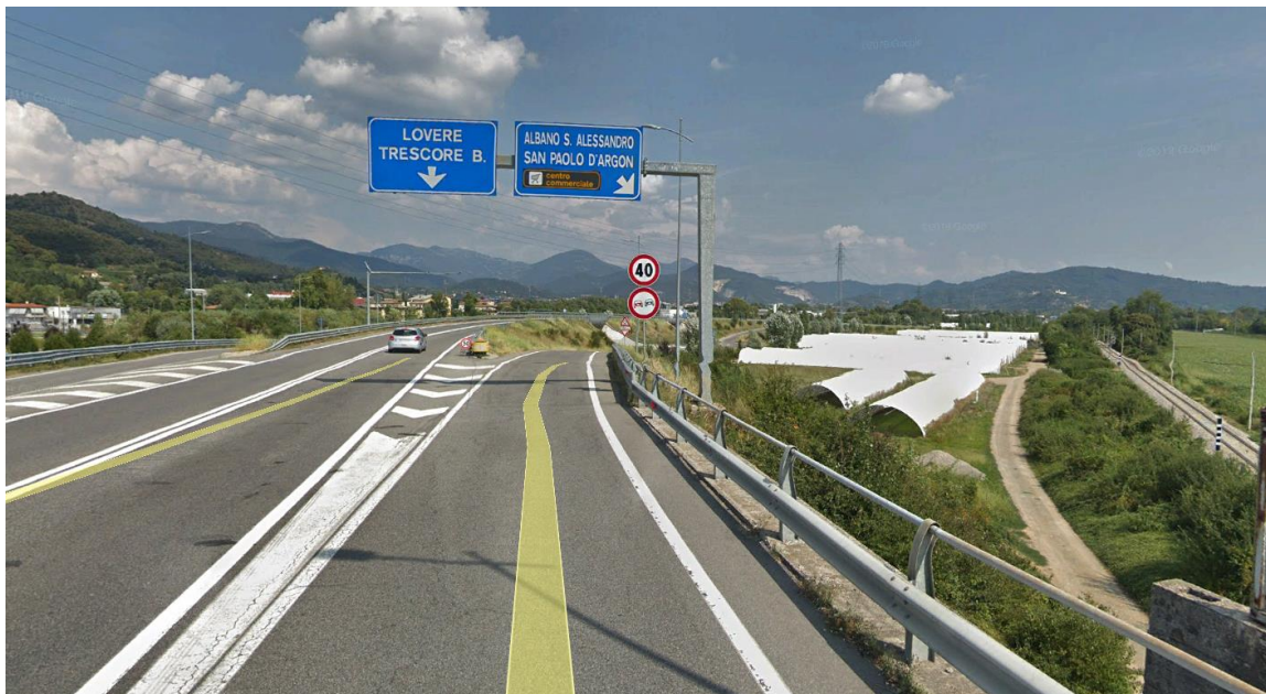
Foto 2 – vista della viabilità di accesso al cantiere
