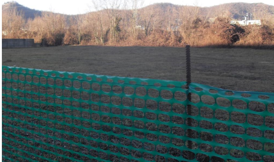
Foto 1 – vista dell'area di cantiere
