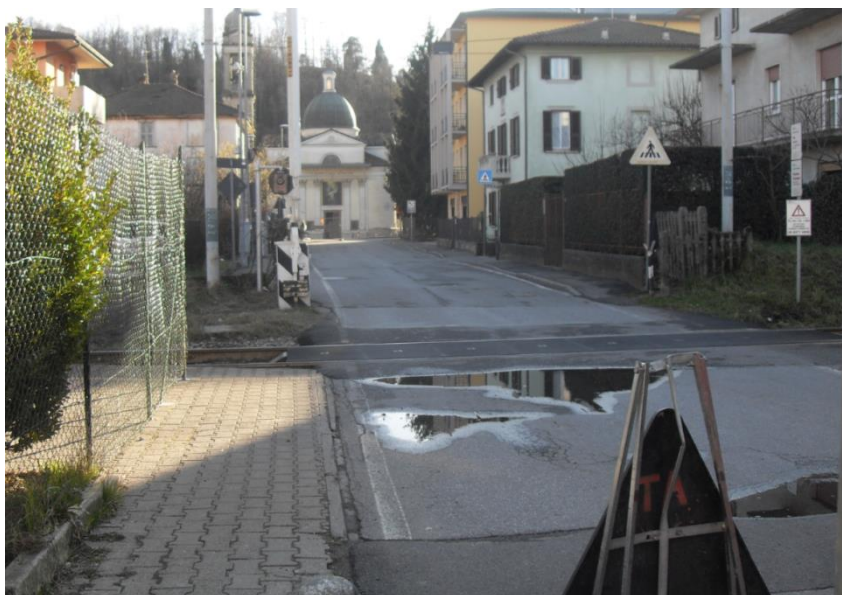
Foto 2 – vista della viabilità di accesso al cantiere e PL
