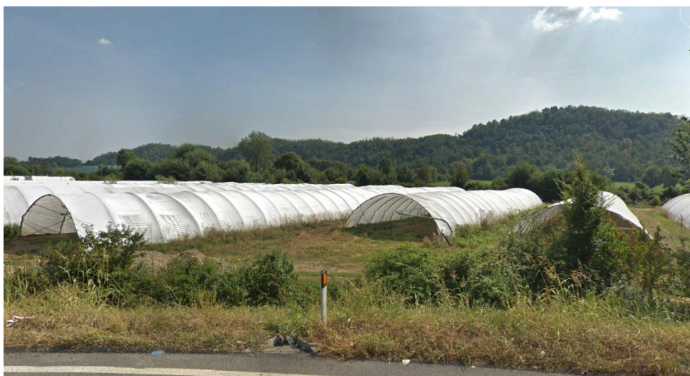
Vista dell'area dove andrà aperta la pista di cantiere - lato nord – rotatoria esistente (vista delle serre da rimuovere)
