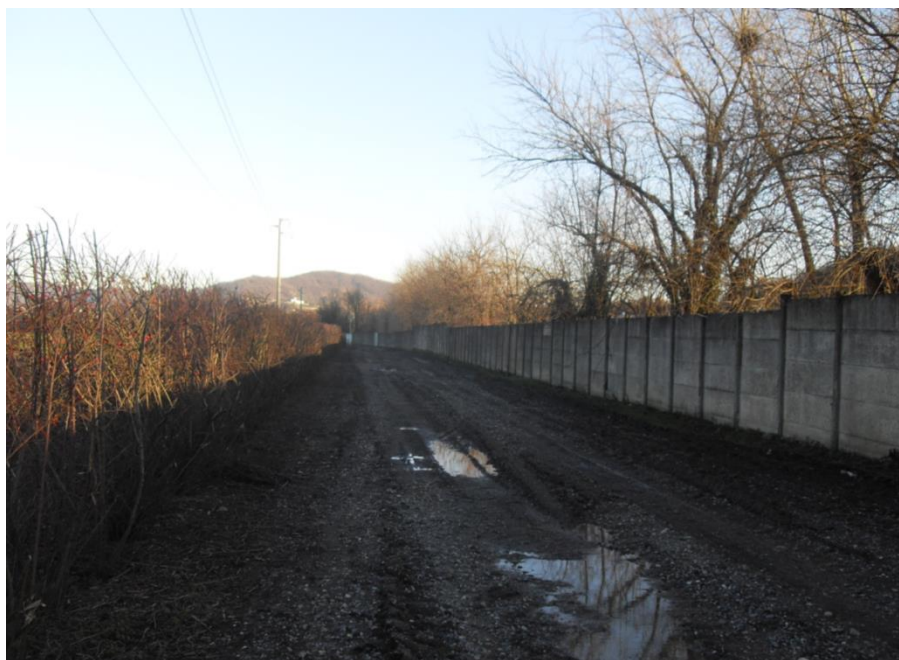
Vista della viabilità di accesso al cantiere - lato sud – via F Filzi (fonte sopralluogo)
