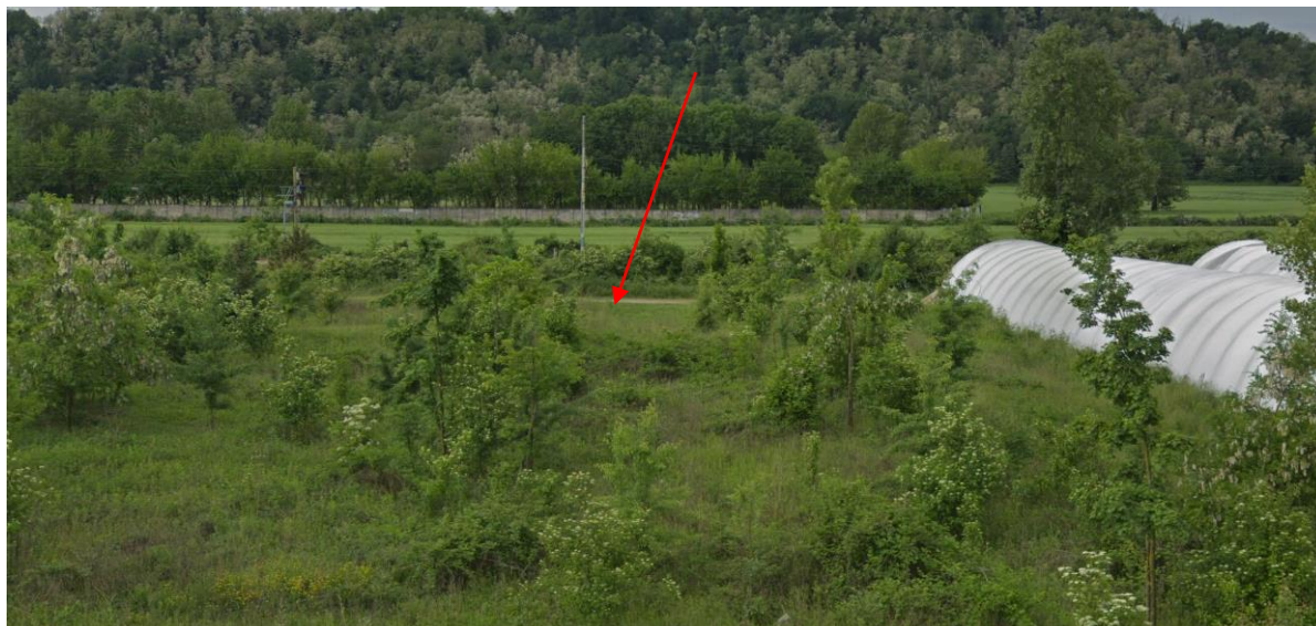
Foto 1 – Vista delle aree di cantiere dalla SS42 (sul lato sud della linea ferroviaria)
