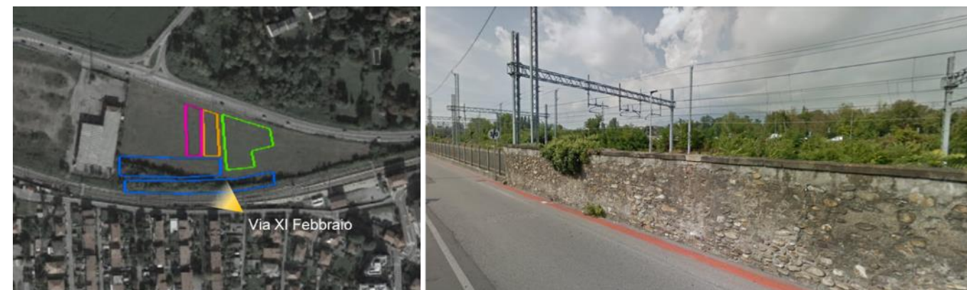
Figura 6-55 Aree di cantiere nei pressi della Stazione ferroviaria di Ponte San Pietro: visuale da Via XI Febbraio
