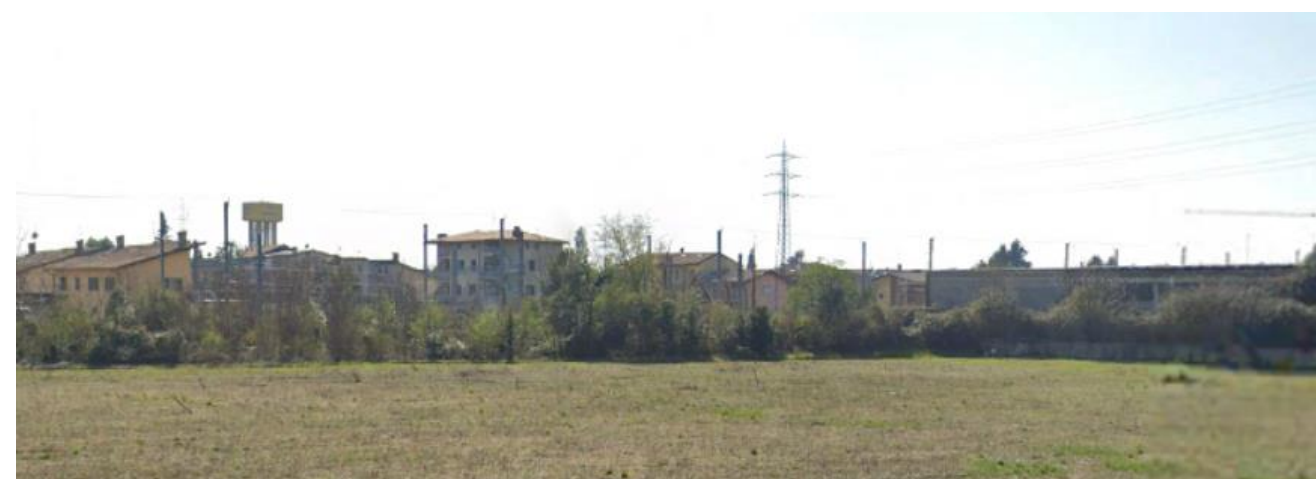
Figura 6-23 Rilievo fotografico dell'area di cantiere fisso 1.AR.02
