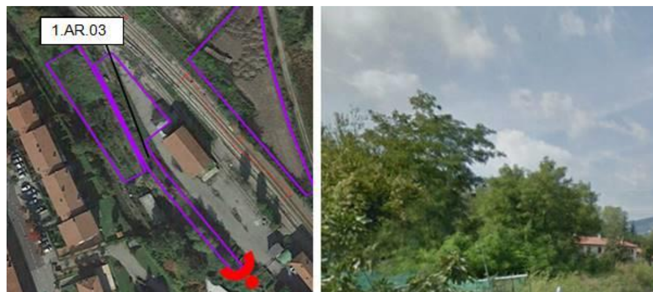
Figura 6-28 Area di cantiere fisso 1.AR.03 su foto aerea e rilievo fotografico
