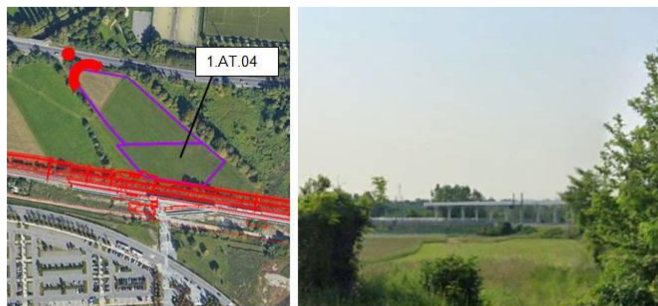
Figura 6-21 Area di cantiere fisso 1.AT.04 su foto aerea e rilievo fotografico
