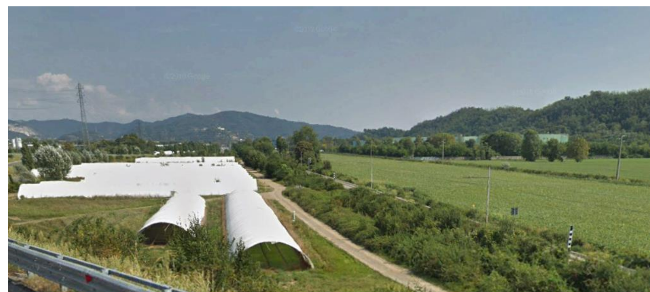
Figura 6-46 Ubicazione e contesto aree di cantiere su seminativi semplici e orti protetti. Lotto 8
