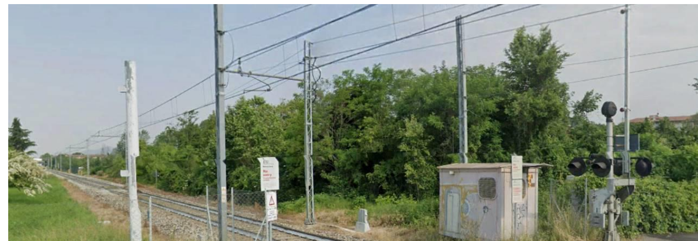
Figura 6-35 Pk 2+350-3+000 – Lotto 2. Rilievo fotografico dell'area
