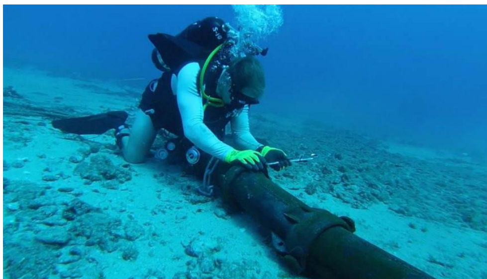
Figura 5.14 – Sistema “a gusci” per la protezione dei cavi
