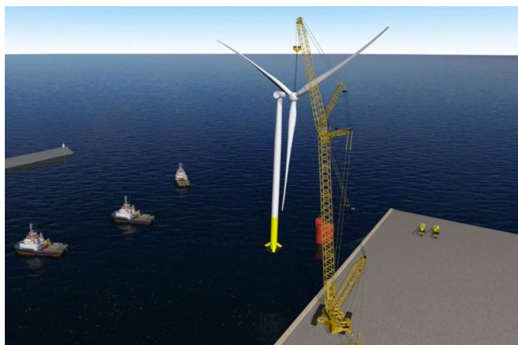
Figura 6.3 – Operazione di sollevamento del rotore (Fonte: SOT A/S)
