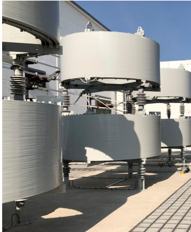
Figura 4.1 – Compensazione del reattivo - sottostazione di consegna
