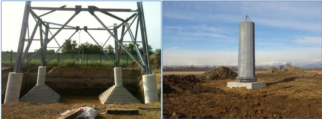
*Figura 26: Esempio di sostegno a traliccio (a sinistra) e di sostegno tubolare monostelo (a destra)*
