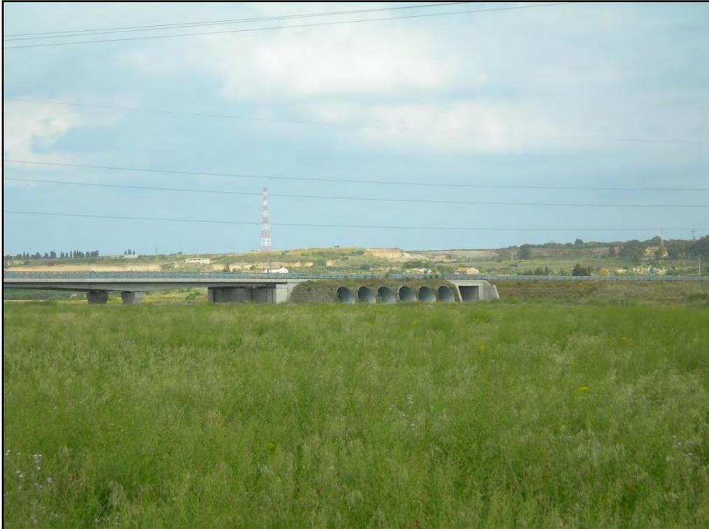
*Figura 86: Autostrada A18 vista da Ovest:luci secondarie circolari e sottopasso stradale*
