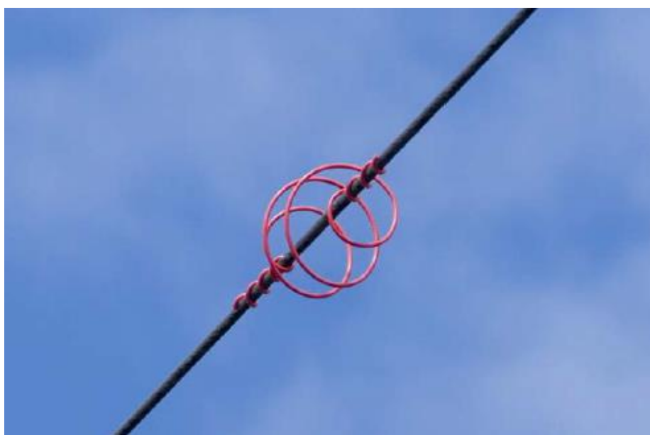
Figura 7-I. Spirale colorata in plastica per la segnalazione dei cavi
