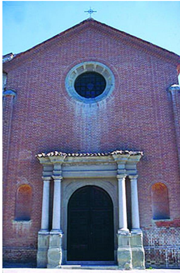
Figura 4.7.6 – Vista dell'esterno della chiesetta
