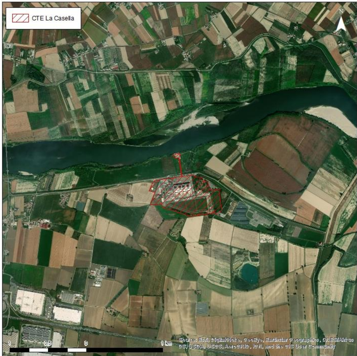
Figura 1.4.1 – Localizzazione della Centrale Termoelettrica di La Casella
