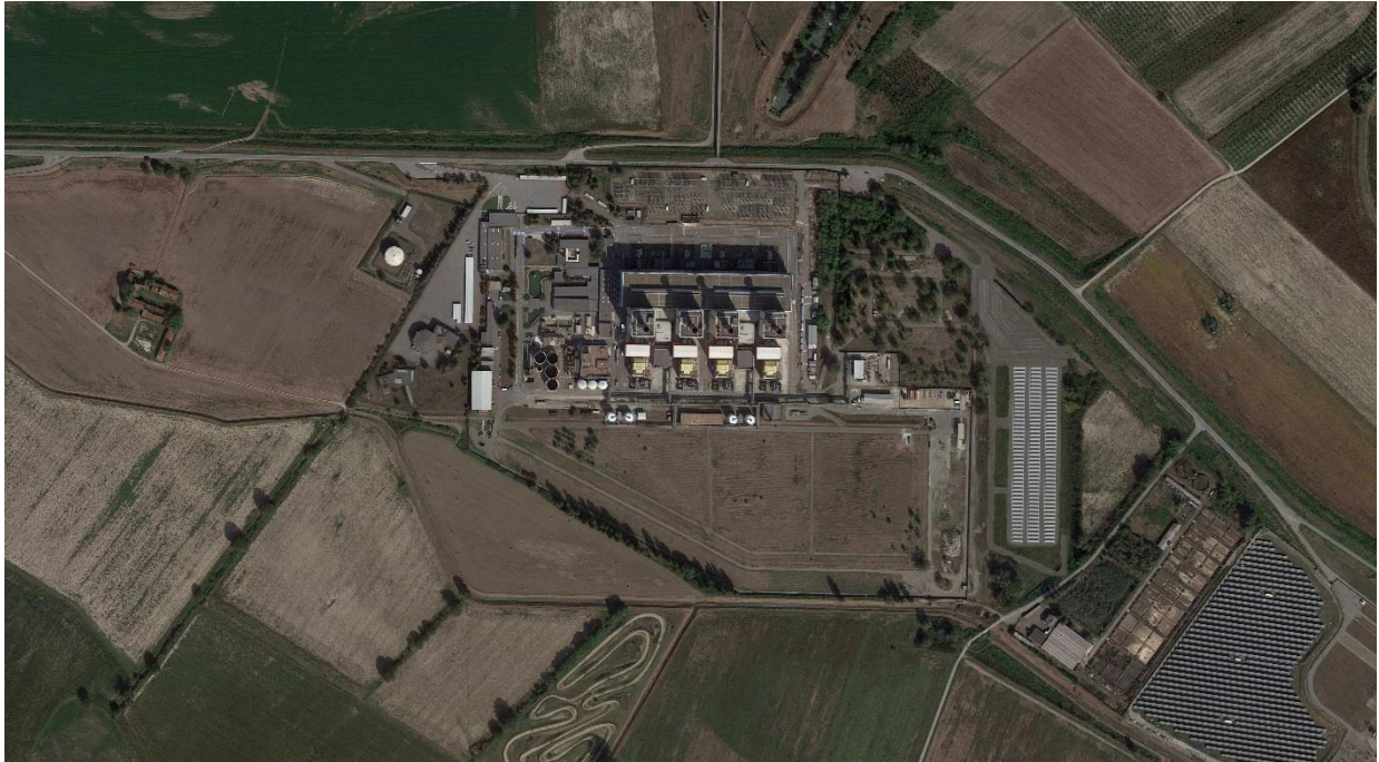
Figura 4.7.21 – Vista zenitale– Ante operam
