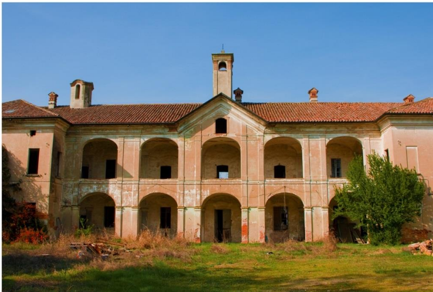
Figura 4.7.10 – Vista del fronte principale della cascina
