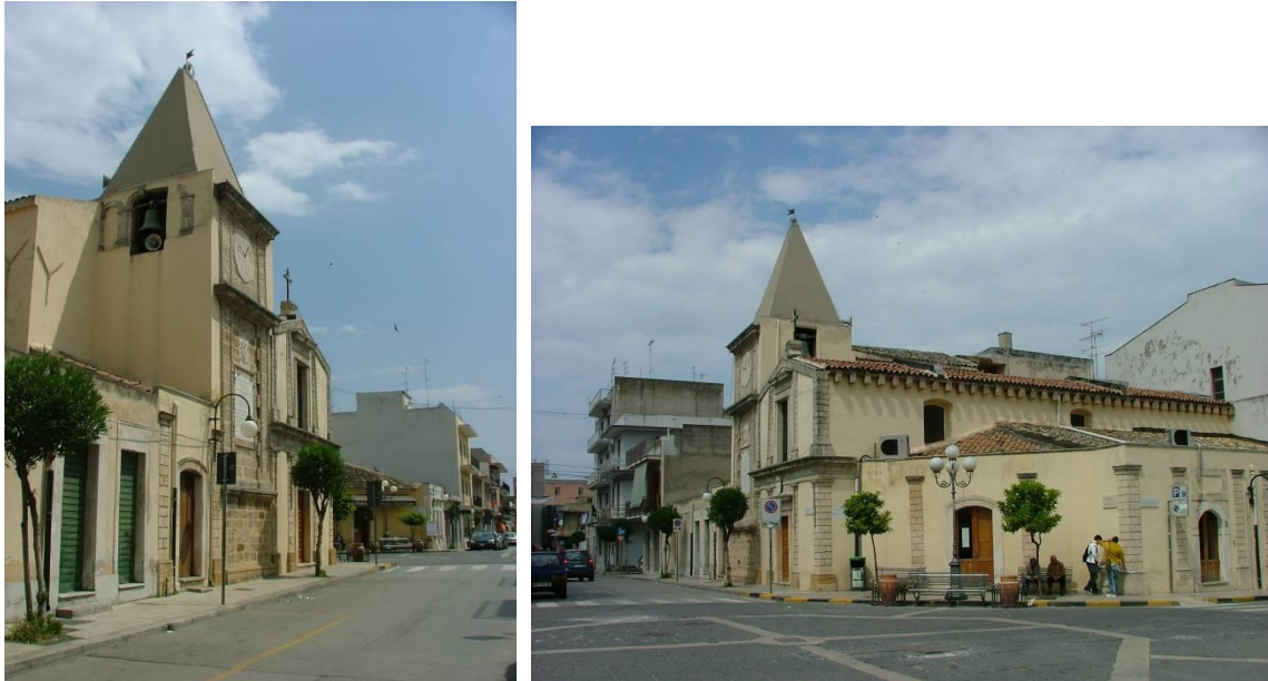
Figura 4.7.6 – Chiesa dell’angelo Custode e piazza dei Quattro Canti
