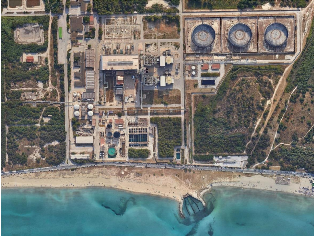
Figura 4.7.27 – Vista zenitale– Ante operam
