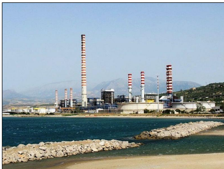
Figura 3.2.1: Immagine dello stato attuale della centrale
