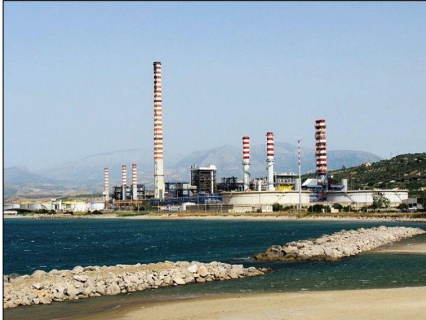
Figura 4.2.1: Immagine dello stato attuale della centrale
