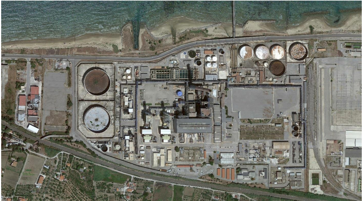
Figura 5.4.7 – Vista zenitale– Ante operam
