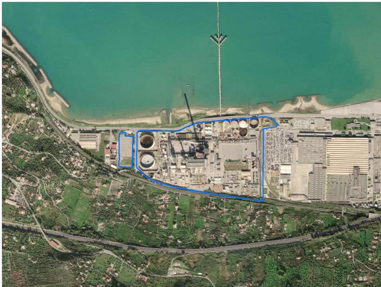
Figura 2.3.1 – Ubicazione della Centrale “Ettore Majorana” di Termini Imerese
