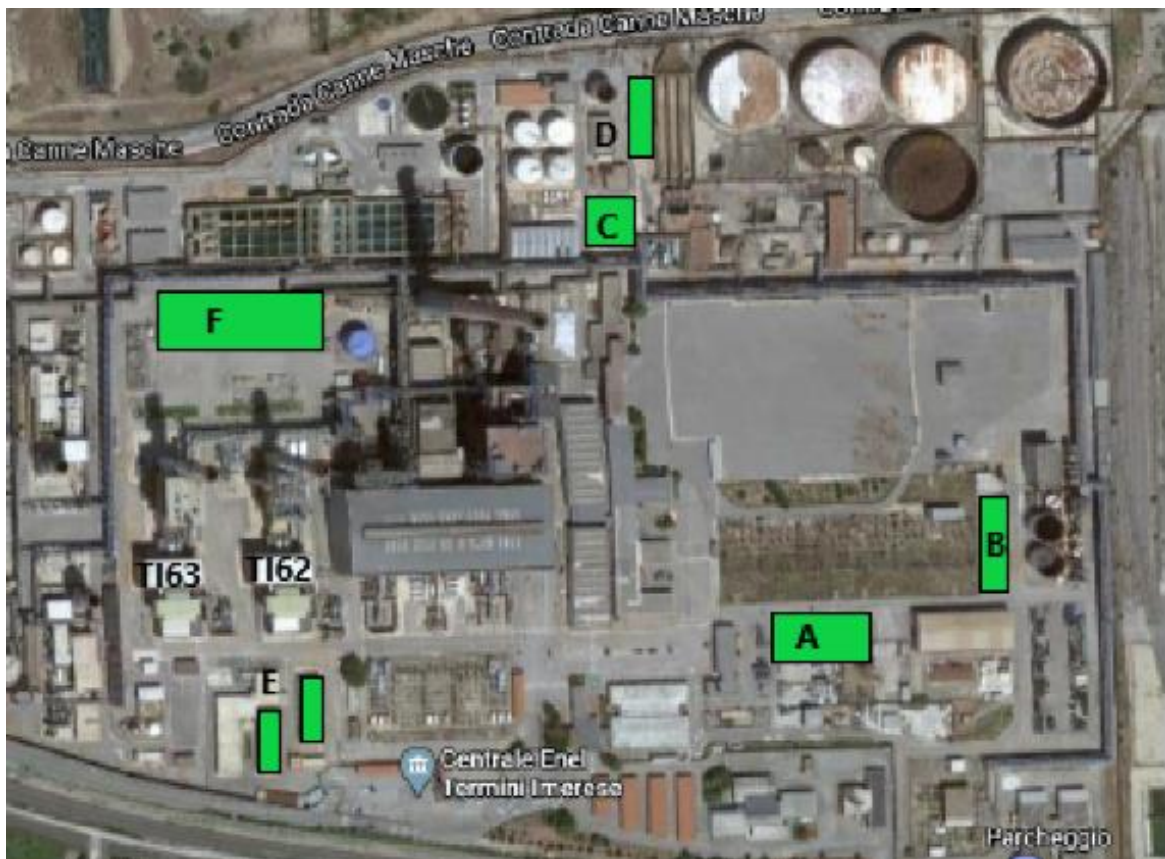
Area di Cantiere
