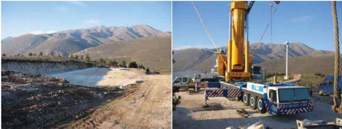
Figura 17: piazzole e gru per il montaggio pale
