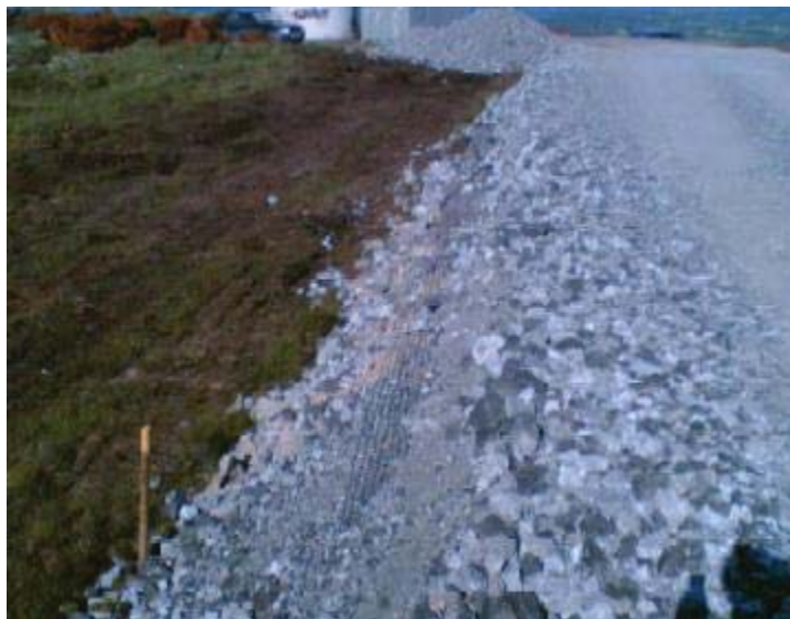
Figura 14 Superficie stradale in misto stabilizzato e drenaggio
