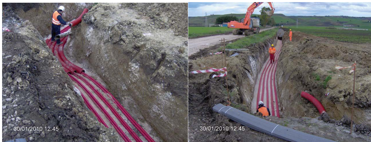
Figura 21: posa in opera dei cavi
