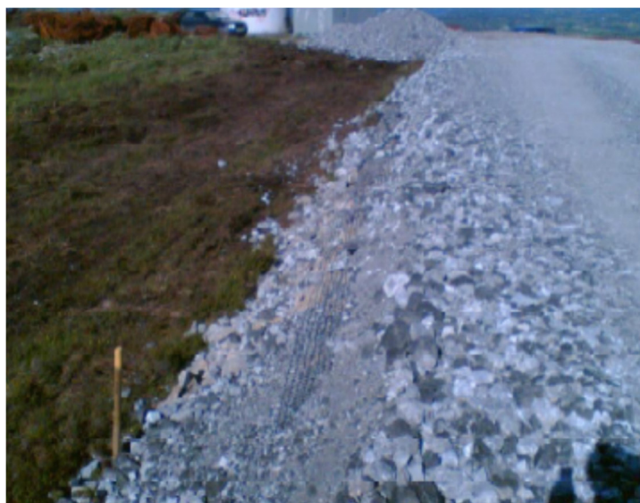
Figura 3: Superficie stradale in misto stabilizzato e drenaggio
