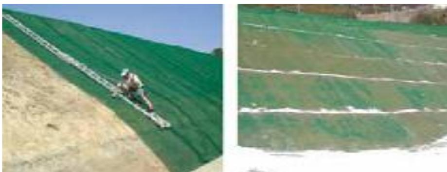
Fig. 19 - Esempio realizzativi con geostuoia
