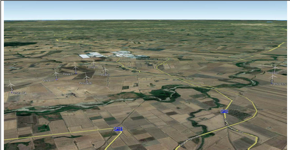
Vista di insieme degli aerogeneratori
