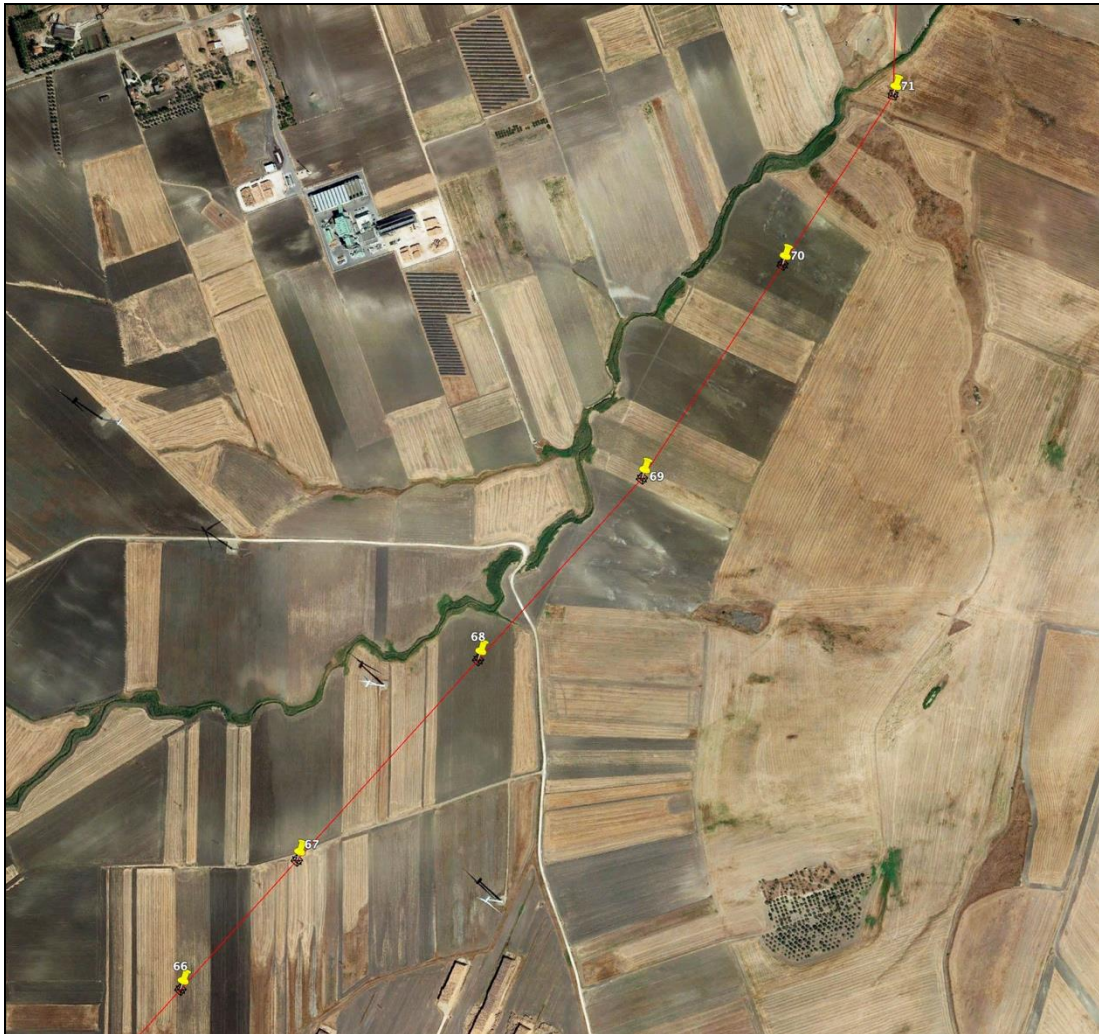
Figura 14 - Ubicazione dell'opera su foto aerea: sostegni n. 66-67-68-69-70-71
