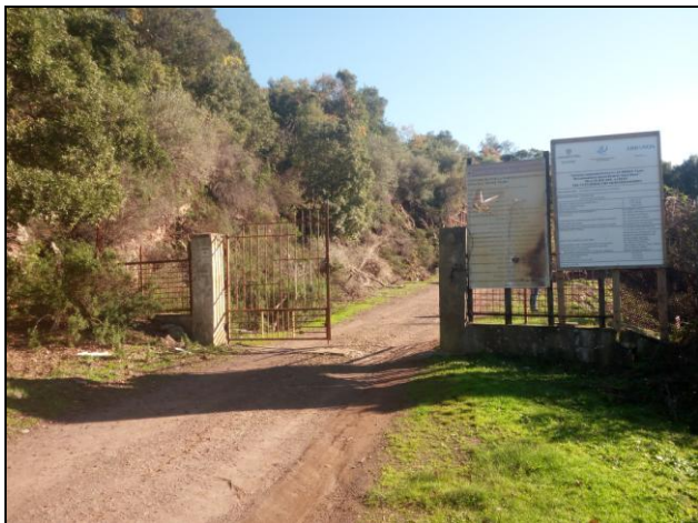
Figura 14 Strada di accesso alla diga
