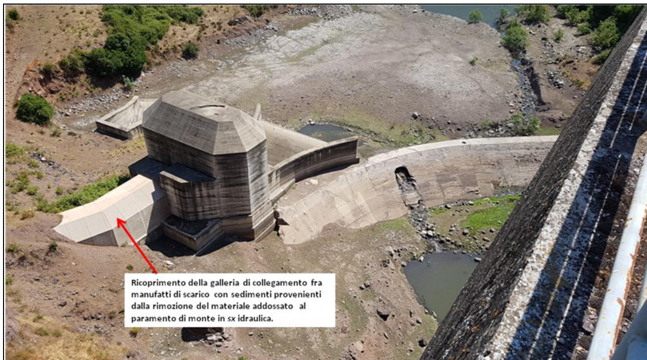
Figura 11 - Intervento sulla galleria di collegamento fra manufatti di scarico
