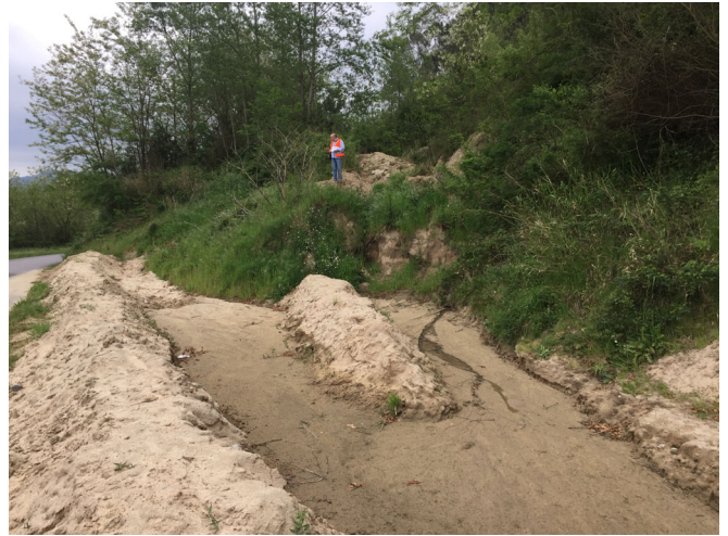
Foto 4.9 -Terreni di riporto posti in corrispondenza dell'incrocio con la viabilità comunale esistente
