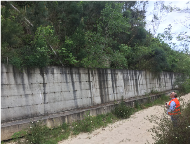
Foto 4.8 – Terreni di riporto antistanti il muro di contenimento esistente posto in corrispondenza del tratto iniziale
