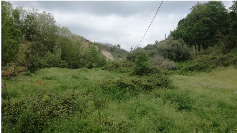
Foto 4.6 - Accumulo di depositi eluvio-colluviali
