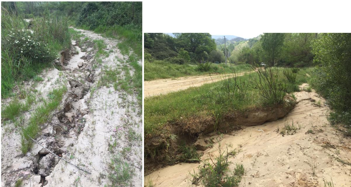
**Foto 8.2 - Esempio di processi di erosione concentrata agenti lungo il tracciato in progetto**
