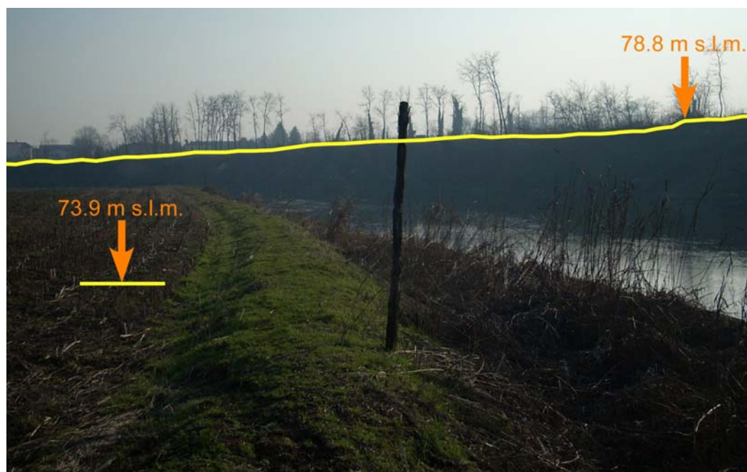
Fig. 4 - Superfici terrazzate poste a diversa quota a valle del ponte sul F.Lambro.
