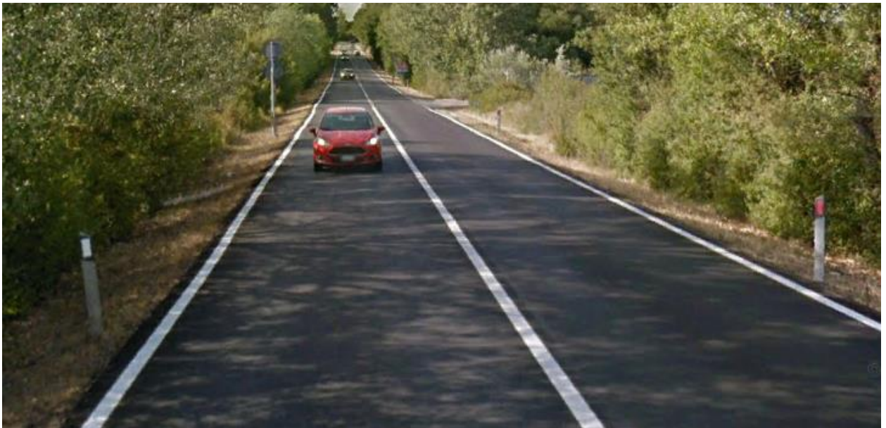
Figura 12 – Assenza di banchine e ridotti margini laterali
