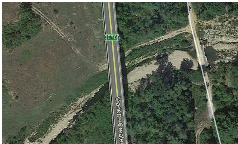
Figura 1 – Viadotto Ornate e viabilità complanare esistente
