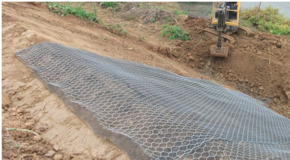
Figura 6 Rivestimento del rilevato con rete antinutria
