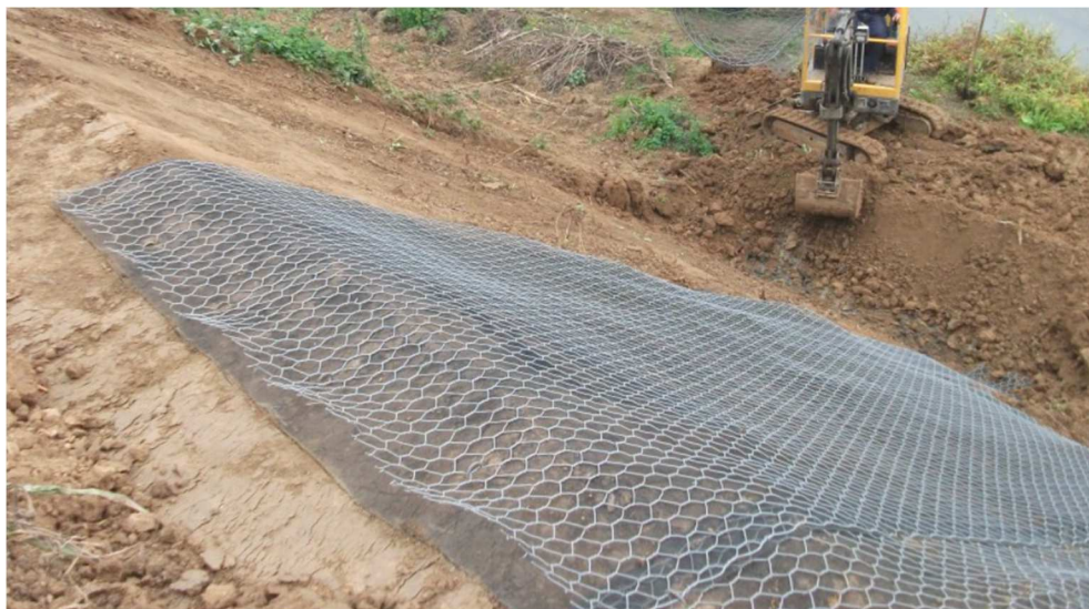
Figura 5-13 - Rivestimento del rilevato con rete antinutria.
