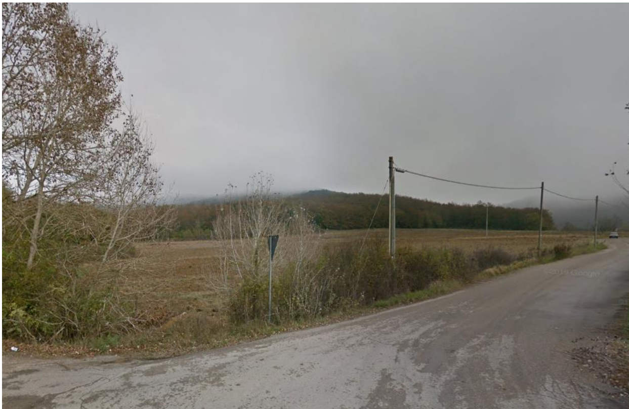
Figura 3.5 – Area cantiere base.
