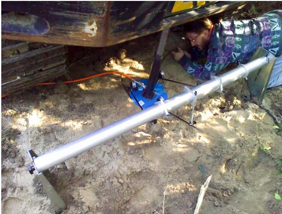
Foto 1 - Prova di carico PZ1_D
