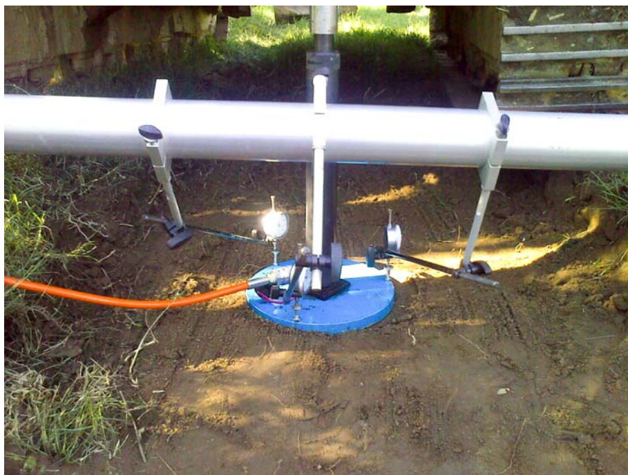
Foto 7 - Prova di carico PZ5_D
