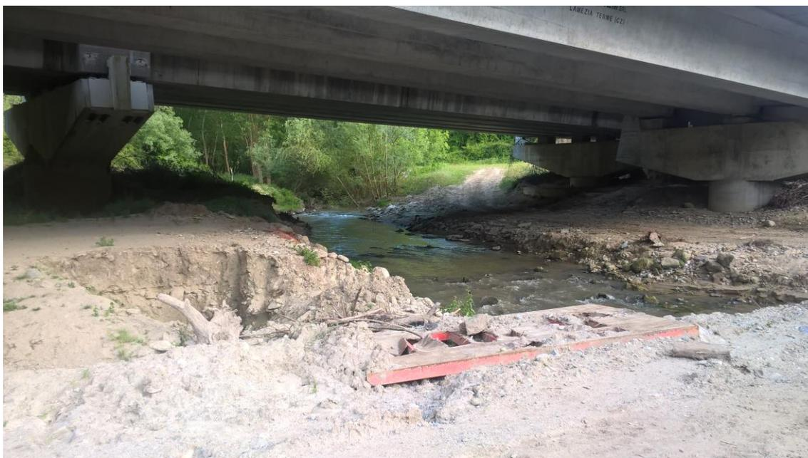
La piena di progetto tende a mandare in pressione l'opera con sormonto dell'impalcato da parte della vena fluida. Le velocità massime del flusso idrico si attestano su valori molto elevati (6/7 m/s). Considerata la configurazione descritta sono prevedibili importanti azioni di scalzamento
