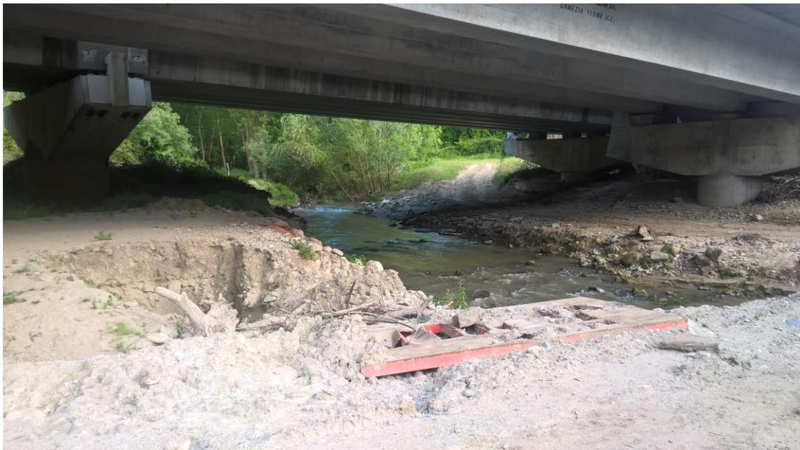
La piena di progetto tende a mandare in pressione l'opera con sormonto dell'impalcato da parte della vena fluida. Le velocità massime del flusso idrico si attestano su valori molto elevati (6/7 m/s). Considerata la configurazione descritta sono prevedibili importanti azioni di scalzamento fondazionale e di spinta idrodinamica sulle opere.
