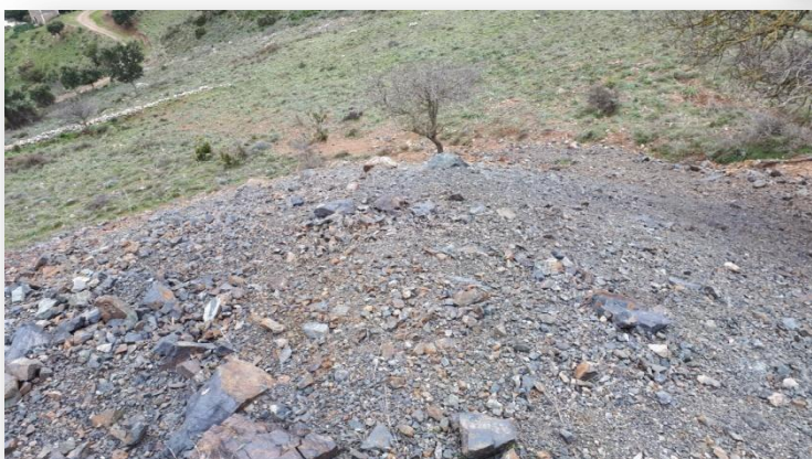
Particolare discariche e cumuli di materiale abbancato
