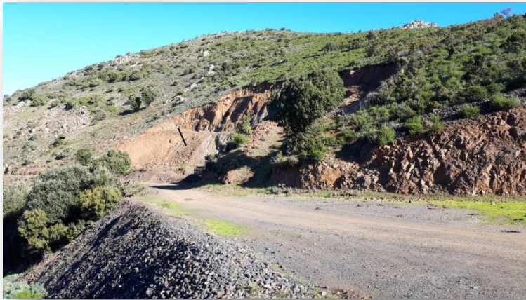
Particolare dello scavo visto dalla strada di accesso al cantiere
