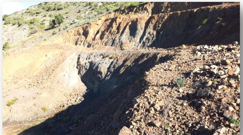
Particolare dei gradoni, discariche e cumuli di materiale abbancato/franato
