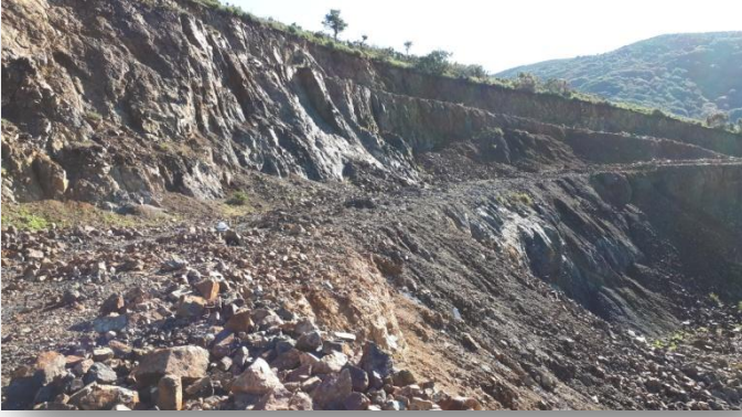
Stato Attuale Cantiere Perdabila
