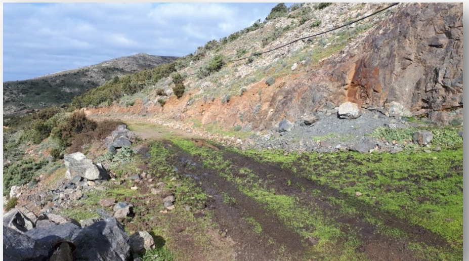
Particolare discariche e cumuli di materiale abbancato
