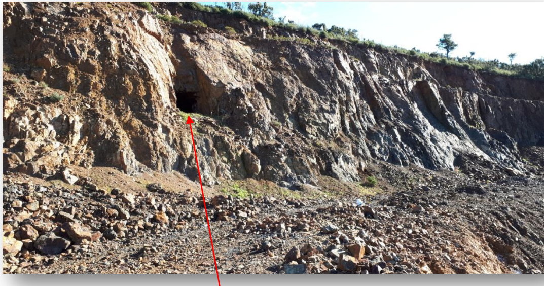
Cantiere Perdabila - Imbocco Galleria n. 20 – livello 848,07 m s.l.m.
