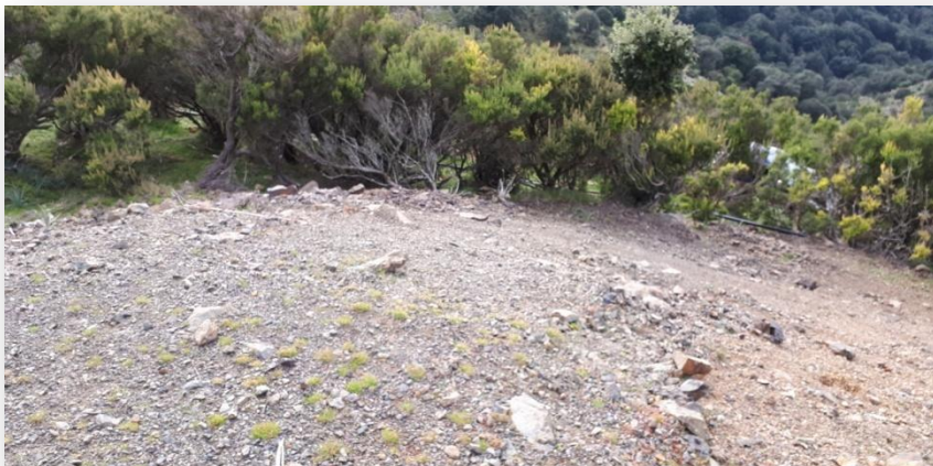
Particolare discariche e cumuli di materiale abbancato Gallerie n.3
