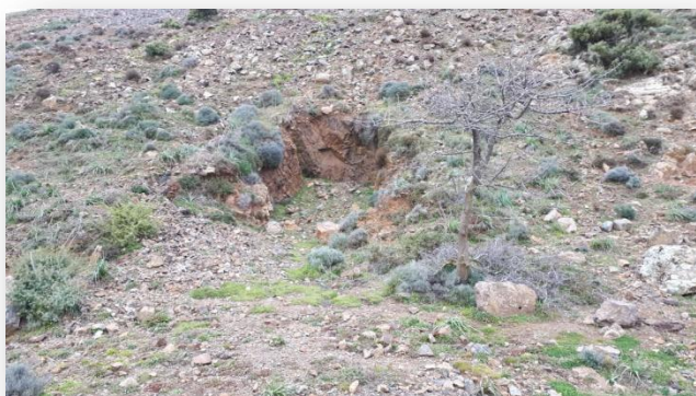
Frana Imbocco Galleria 41 livello 928 m s.l.m.
