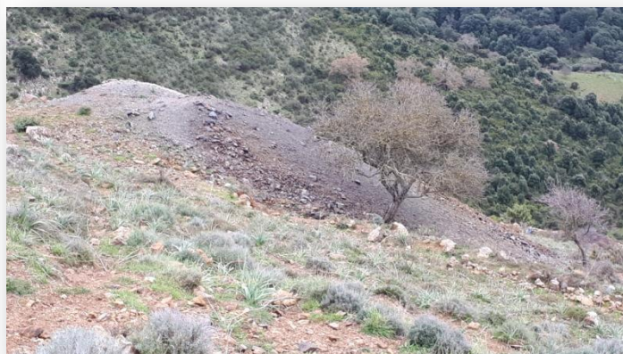
Particolare delle discariche viste dalla strada di accesso al cantiere
