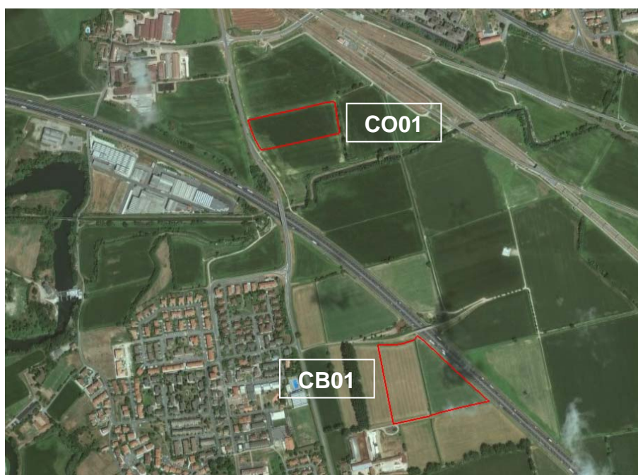
Figura 7-1: localizzazione aree di cantiere. Campo base, cantiere operativo e area di caratterizzazione terre nel sito CB01; cantiere operativo per impianti di produzione conglomerati bituminosi nel sito CO01.
