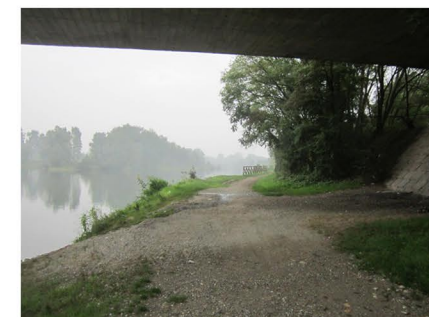
5 - passaggio sotto ponte esistente
