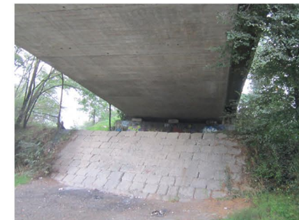
4 - spalla ponte esistente
