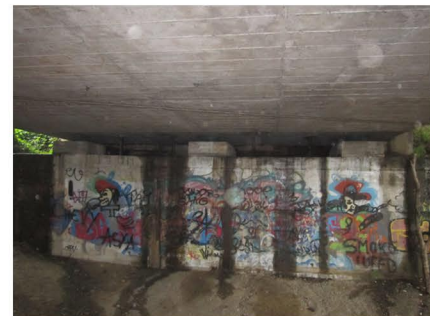
1 - spalla ponte esistente
