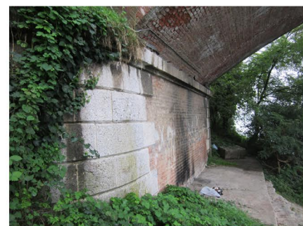
3 - passaggio sotto ponte storico
