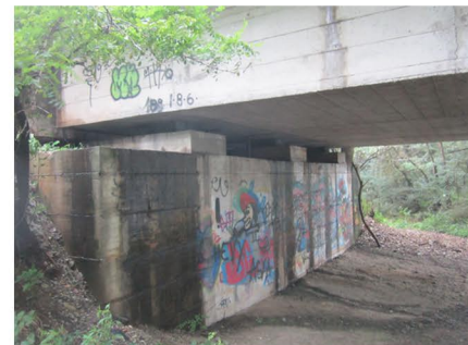
2 - passaggio sotto ponte esistente
