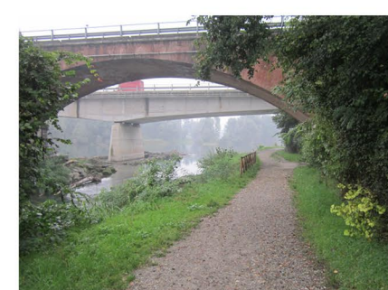
6 - passaggio sotto ponte storico
