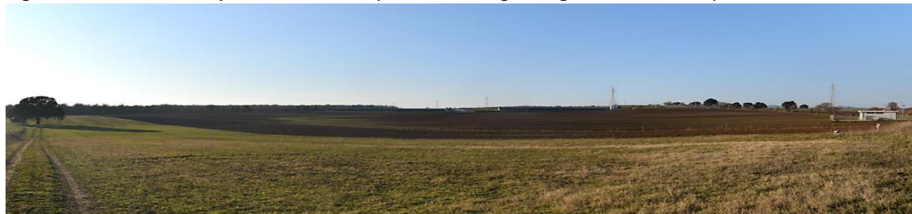
Figura 2.10 Area Nord presso turbine A07 _ A08
