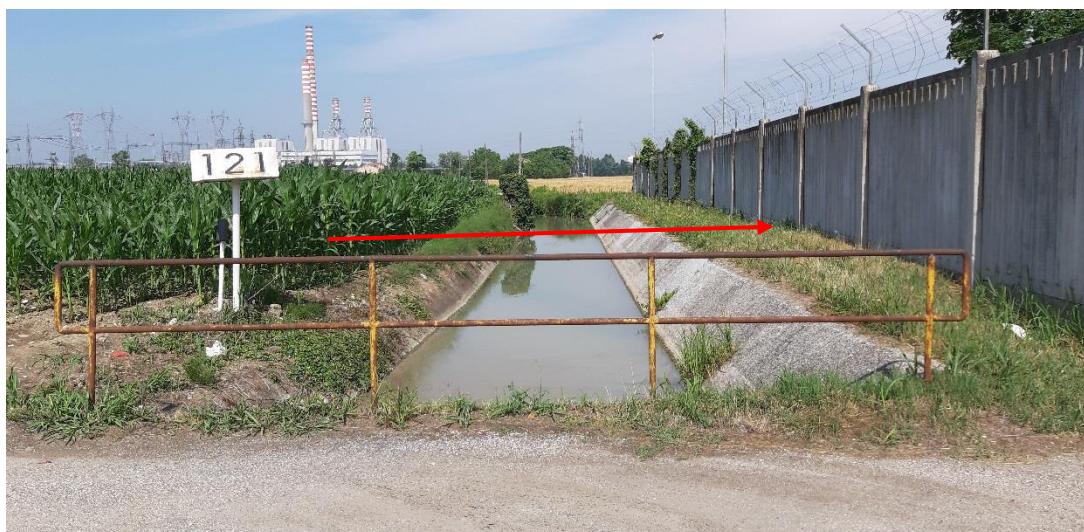
Foto n. 5: Attraversamento Canale Vignale.
