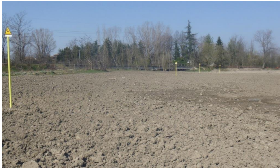
Figura 8.1-H – Pista lavori a ripristini ultimati su un gasdotto in esercizio
