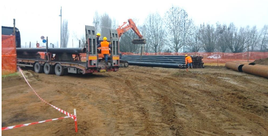
Figura 8.1-A – Foto cantiere piazzola di stoccaggio materiali
