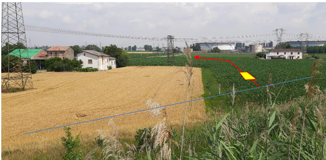
Foto n. 1: Tie-in e area impianto PIDS n.1 in progetto - Panoramica vista dall’argine maestro del Po
