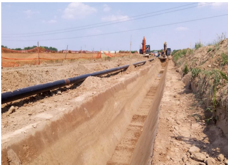
Figura 8.1-E – Foto tipica di scavo della trincea
