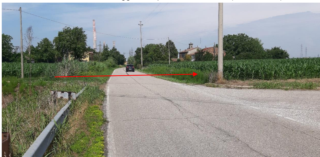
Foto n. 3: Attraversamento strada Via Vignale.
