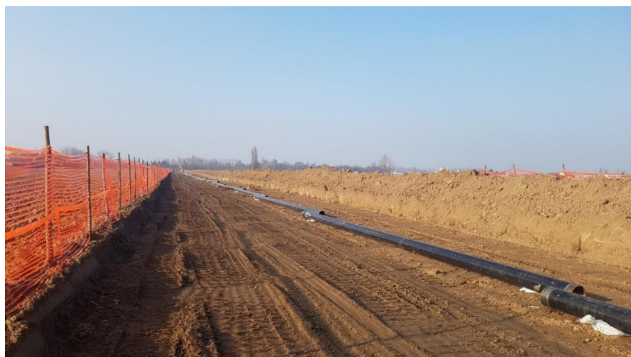
Figura 8.1-D –Sfilamento tubazioni
