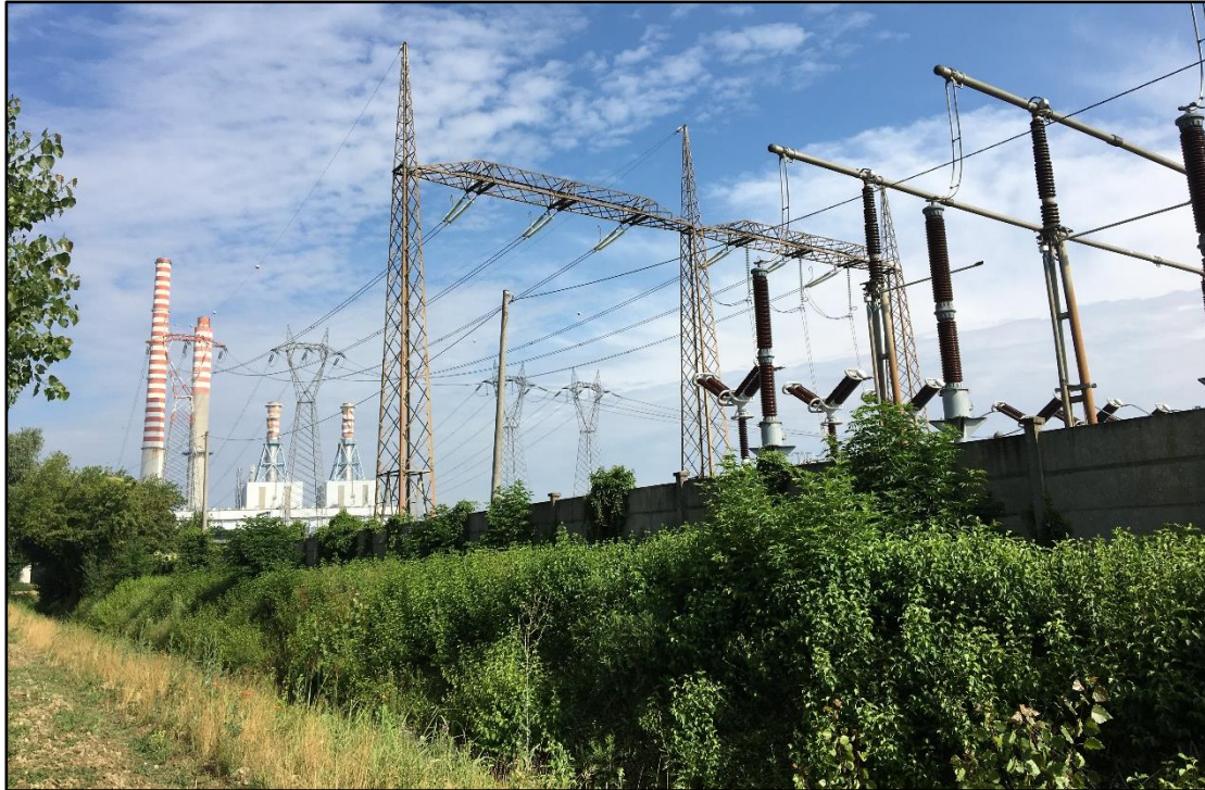
Figura 2.9b Area stallo SE Terna Ostiglia da PV1
