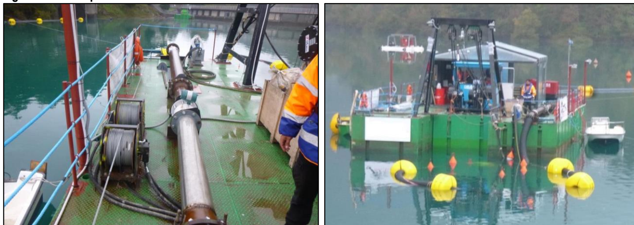
Figura 7-5: esempio di cantiere
