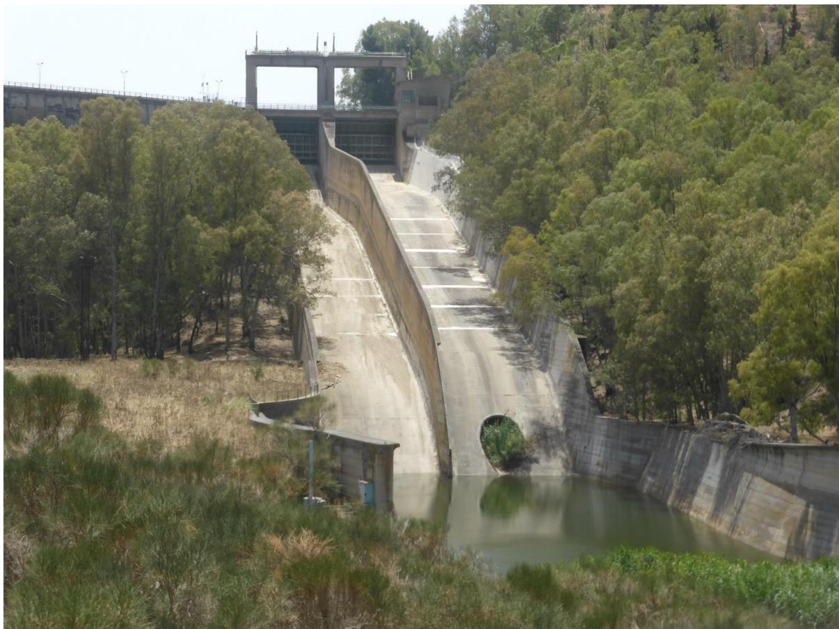
**Figura 5-3. Diga del Pozzillo, scarico di superficie e sbocco della galleria dello scarico di fondo**
