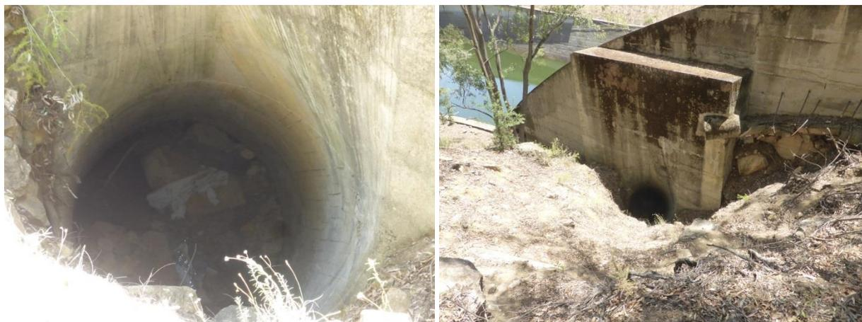
Figura 5-26. Deposito di sedimento all'interno della caditoia intasato dai sedimenti dell'area in dissesto
