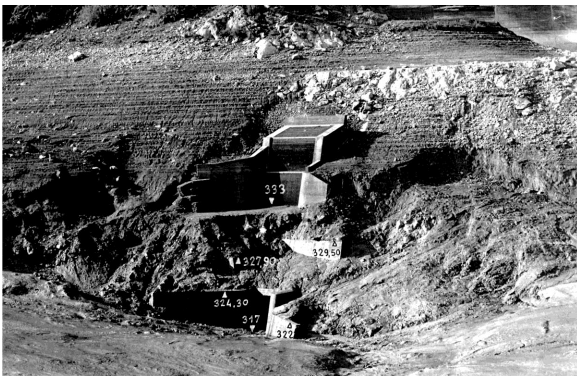
Figura 3.4: Foto storiche dell'opera di derivazione (sopra) e dello scarico di fondo (sotto)
