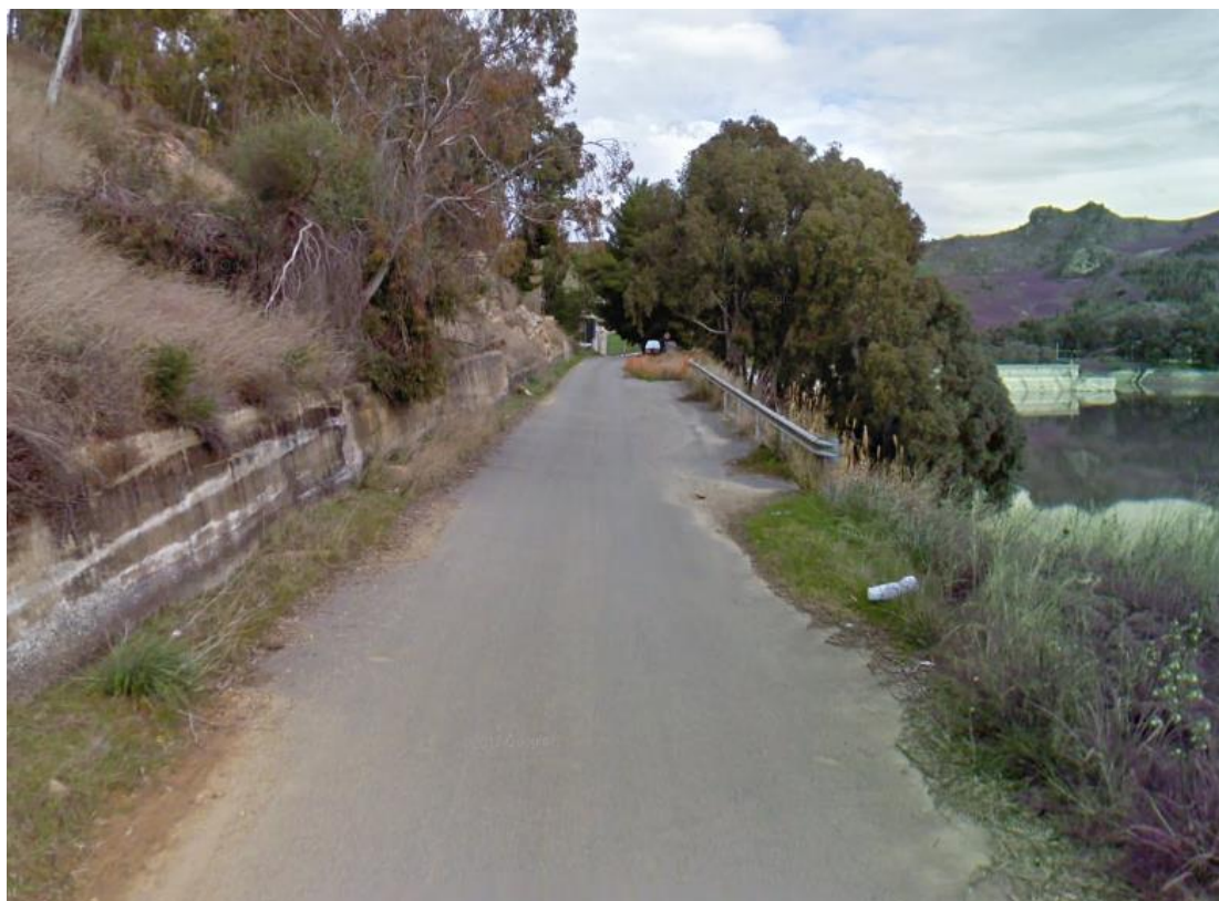
Figura 8.8: Esempio di criticità per la quale è previsto un intervento di Tipo 3
