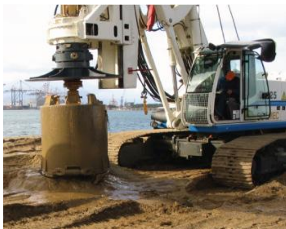
Figura 5.1: tecniche di scavo tradizionali, a sinistra il cucchiaio a destra l'elica continua.
