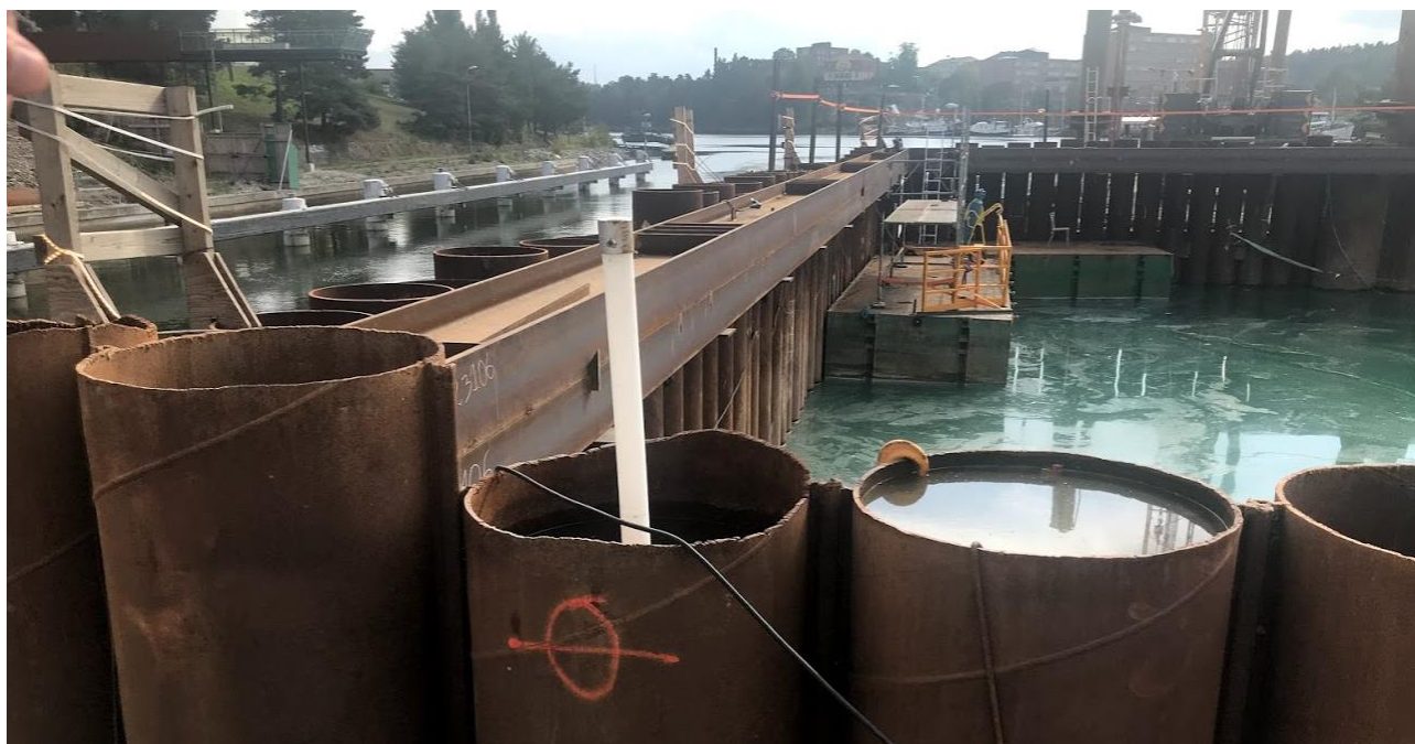
Figura 5.11: Creazione di una vasca a fianco al canale con paratia a tenuta. Notare la differenza di livello idrico tra il canale e la vasca a verifica della perfetta tenuta idraulica del sistema proposto.
