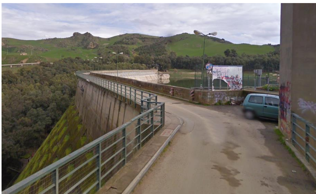
Figura 8.11: Passaggio di limitate dimensioni sul coronamento della diga
