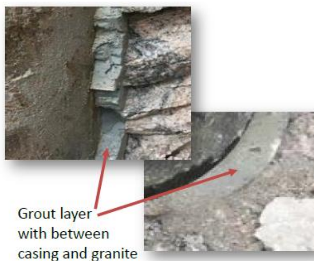
Figura 5.6: Sovrascavo realizzato nel granito e riempito dal betoncino
