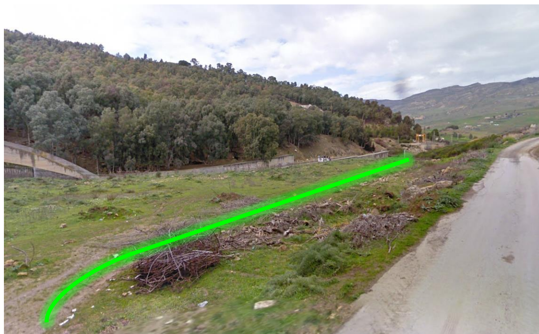
Figura 8.9: Esempio di criticità per la quale è previsto un intervento di Tipo 4
