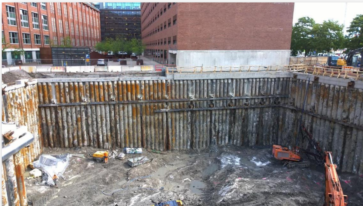
Figura 5.8: Installazione dei pali interconnessi in un cantiere a Skanska, Helsinki.
