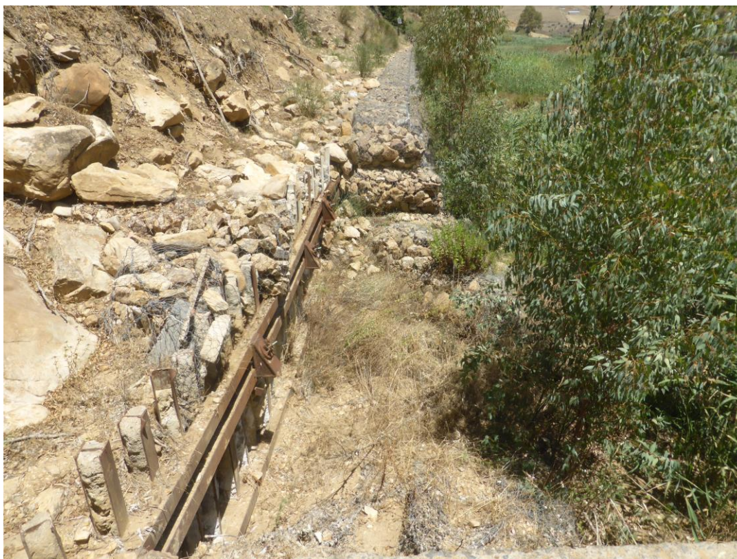
Figura 6.14: Paratia a protezione del versante e gabbioni di protezione in testa.
