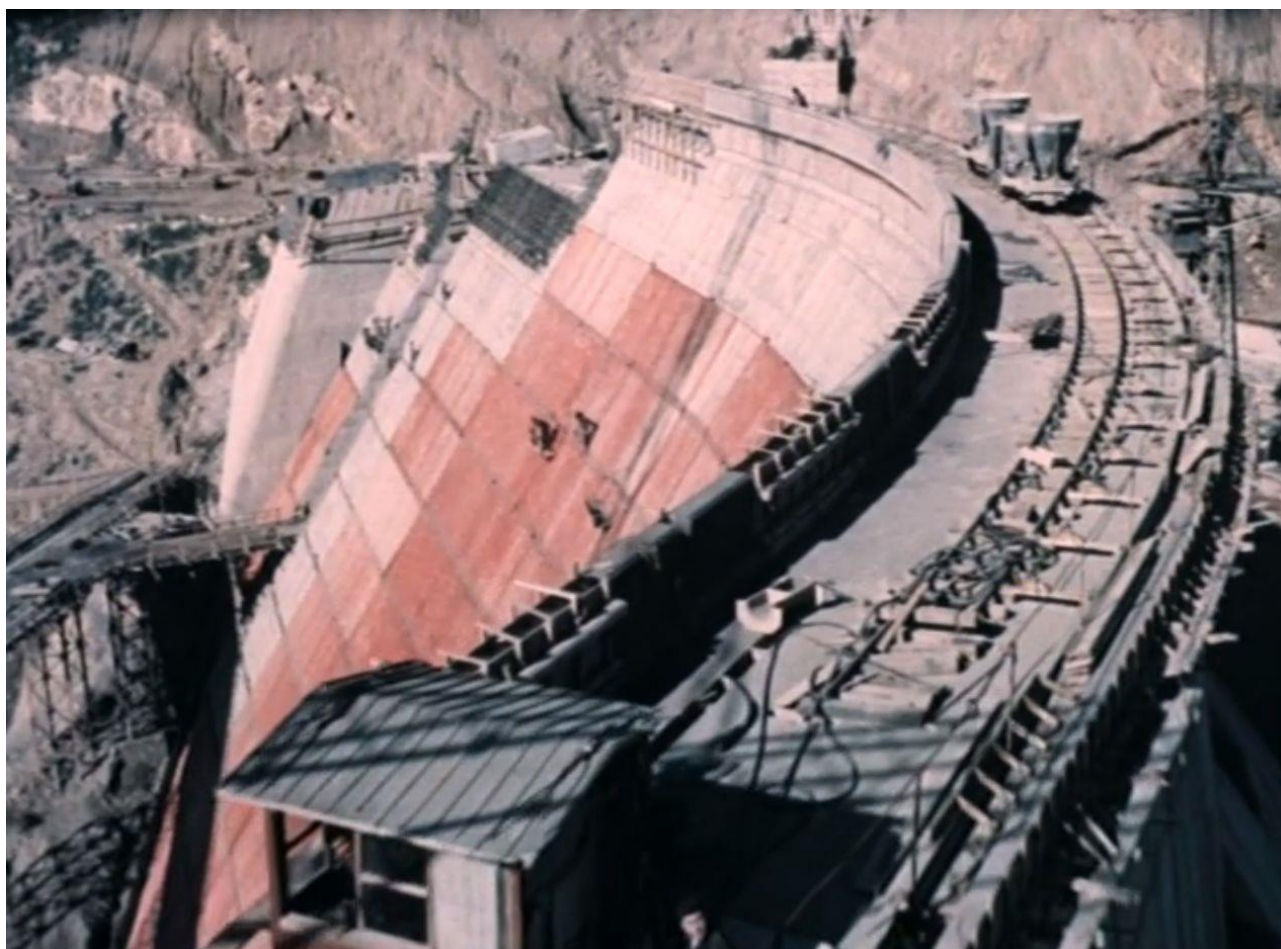
Figura 2.2: La diga di Pozzillo durante la sua costruzione
